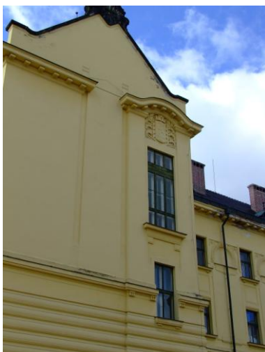
60 - Východní stěna jižního křídla
