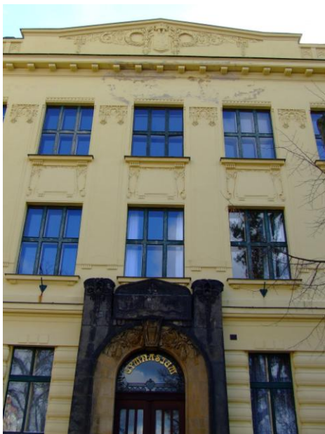
56 – Rizalit severního křídla
