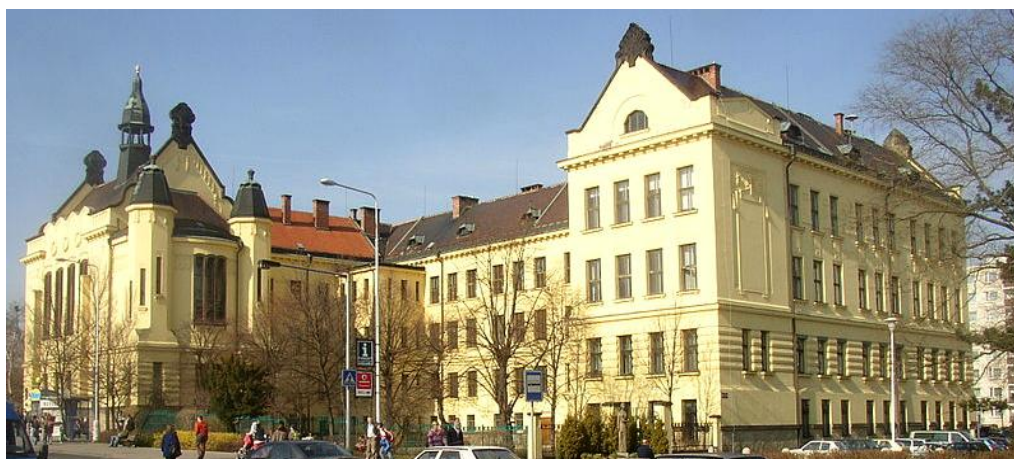
50 - Dnešní celkový pohled na školu
