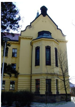
75 - Severní pohled na kapli
