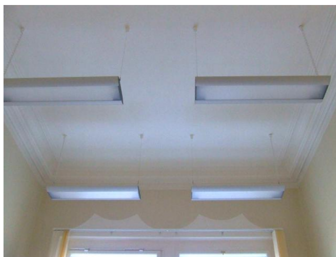
16 - Dochovaná štuková výzdoba bývalé kaple sv. Kříže
