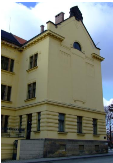
57 - Boční stěna severního křídla
