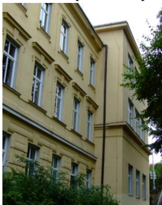
90 – Dnešní pohled na dostavbu z roku 1933
