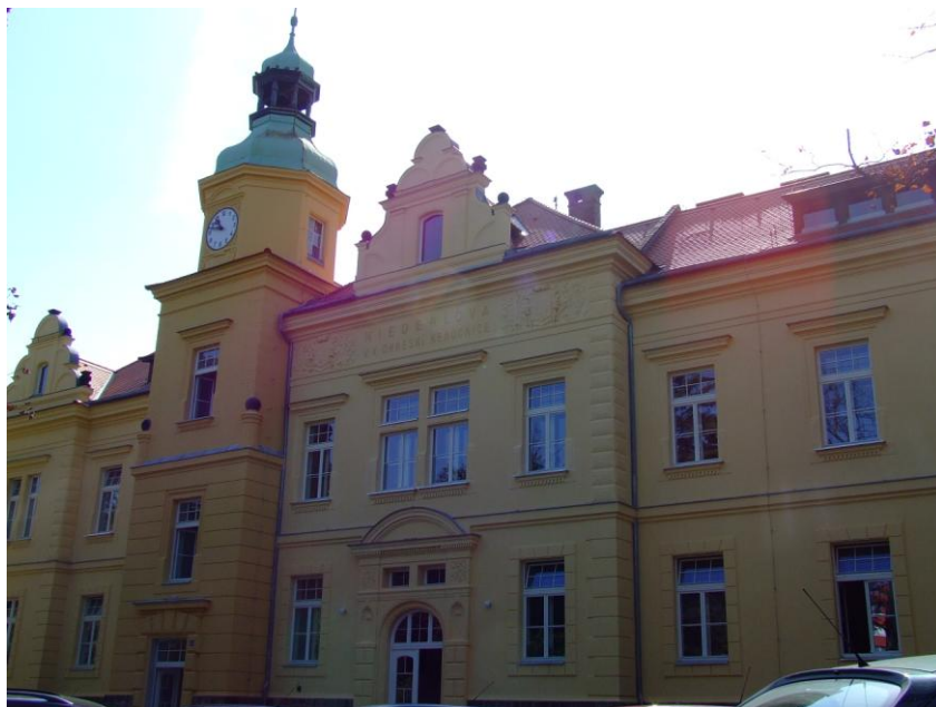
11 - Dnešní zrestaurovaná fasáda Niederlova pavilónu
