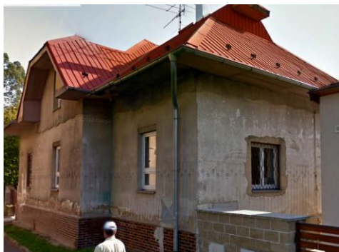
29 – Současný stav budovy
