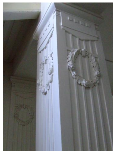
38 - Detail pilíře pod schodišti
