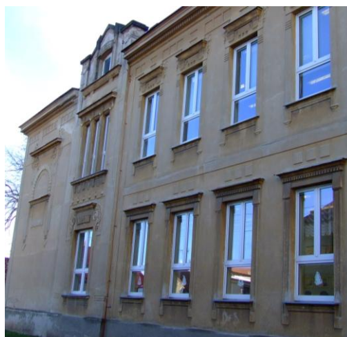
36 – Boční stěna školy
