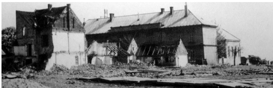
104 – Fotografie zbořeniště s bývalou budovou soudu
