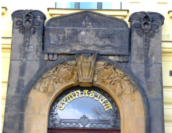
55 – Detail hlavního vchodu školy
