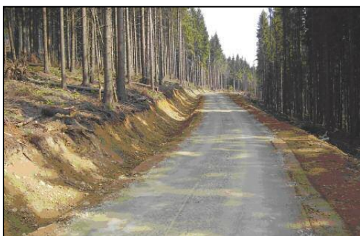
Obr. 1 Lesní odvozní cesta se zpevněním
