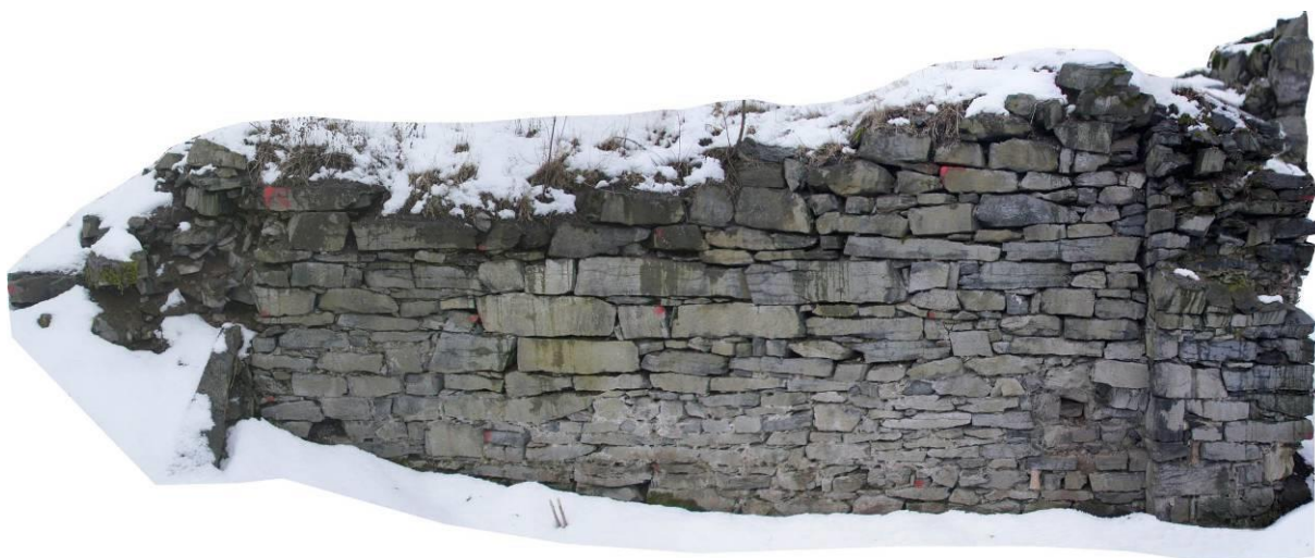
Obr. 28. Kalich. Fotogrammetrie pravé vnitřní stěny brány jádra hradu (P. Hlavenka).
