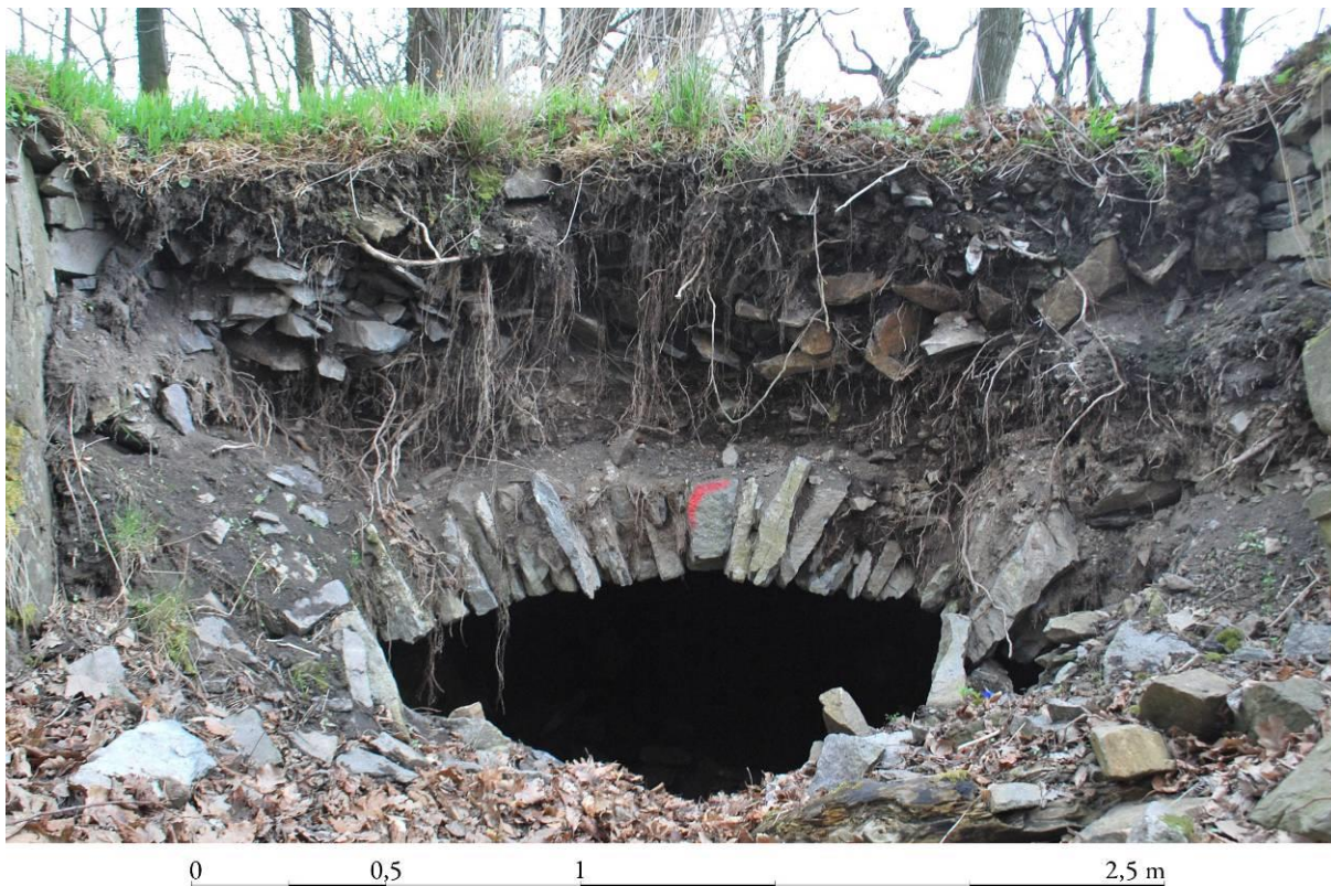
Obr. 29. Kalich. Fotogrammetrie čela paláce jádra hradu (M. Sýkora).
