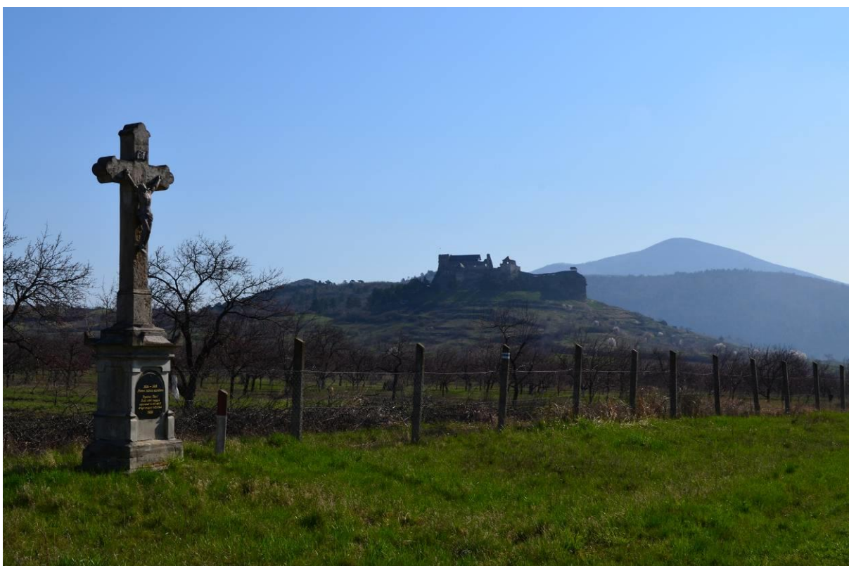
Obr. 142. Boldogkő (HU). Hradu s vysunutým opevněním (foto M. Sýkora).
