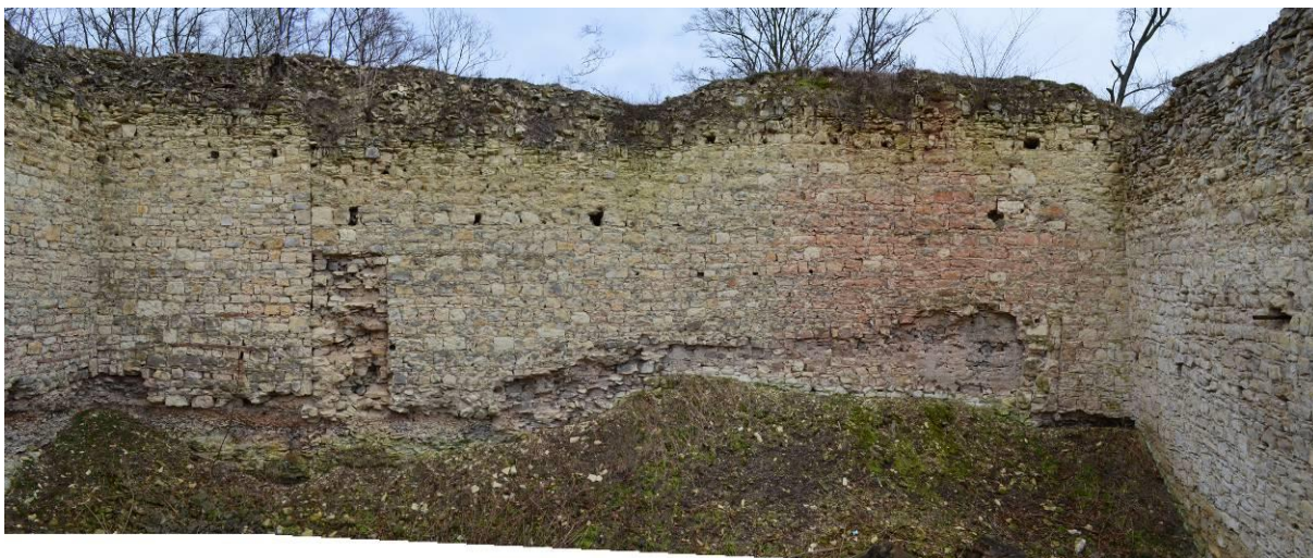
Obr. 89. Pravda. Pohled na hradbu se zbytky nejstarší stavby (foto M. Sýkora).
