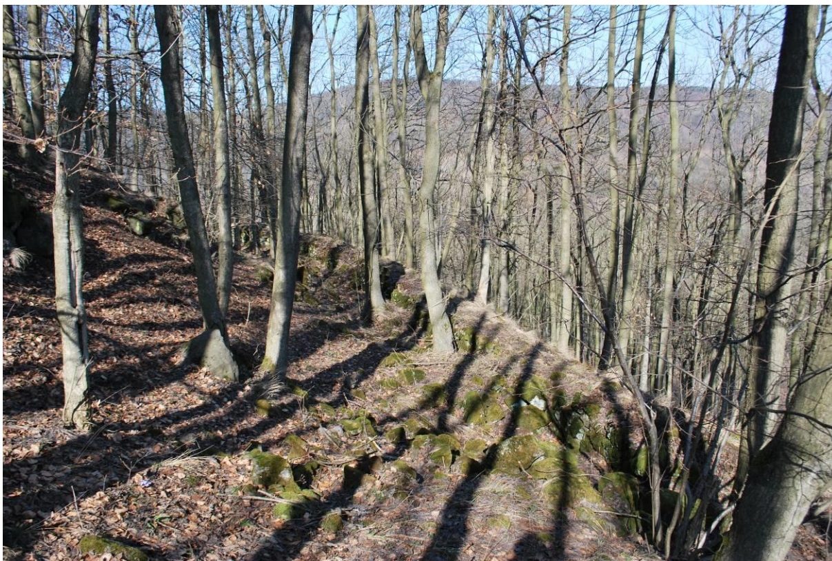
Obr. 7. Himlštejn. Pohled na nasucho zděnou hradbu (foto M. Sýkora).
