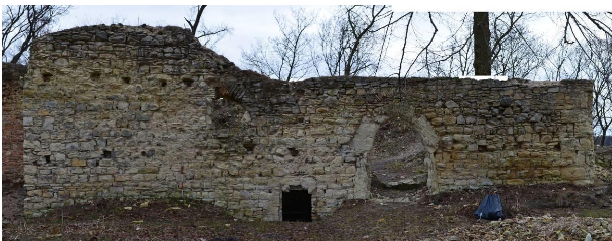
Obr. 88. Pravda. Pohled na stěnu jihovýchodní budovy (foto M. Sýkora).
