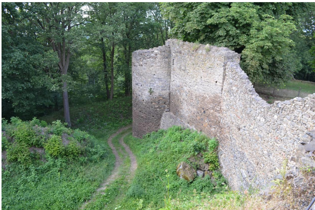
Obr. 63. Klenová. Pohled na severozápadní baštu obezděného valu (foto M. Sýkora).
