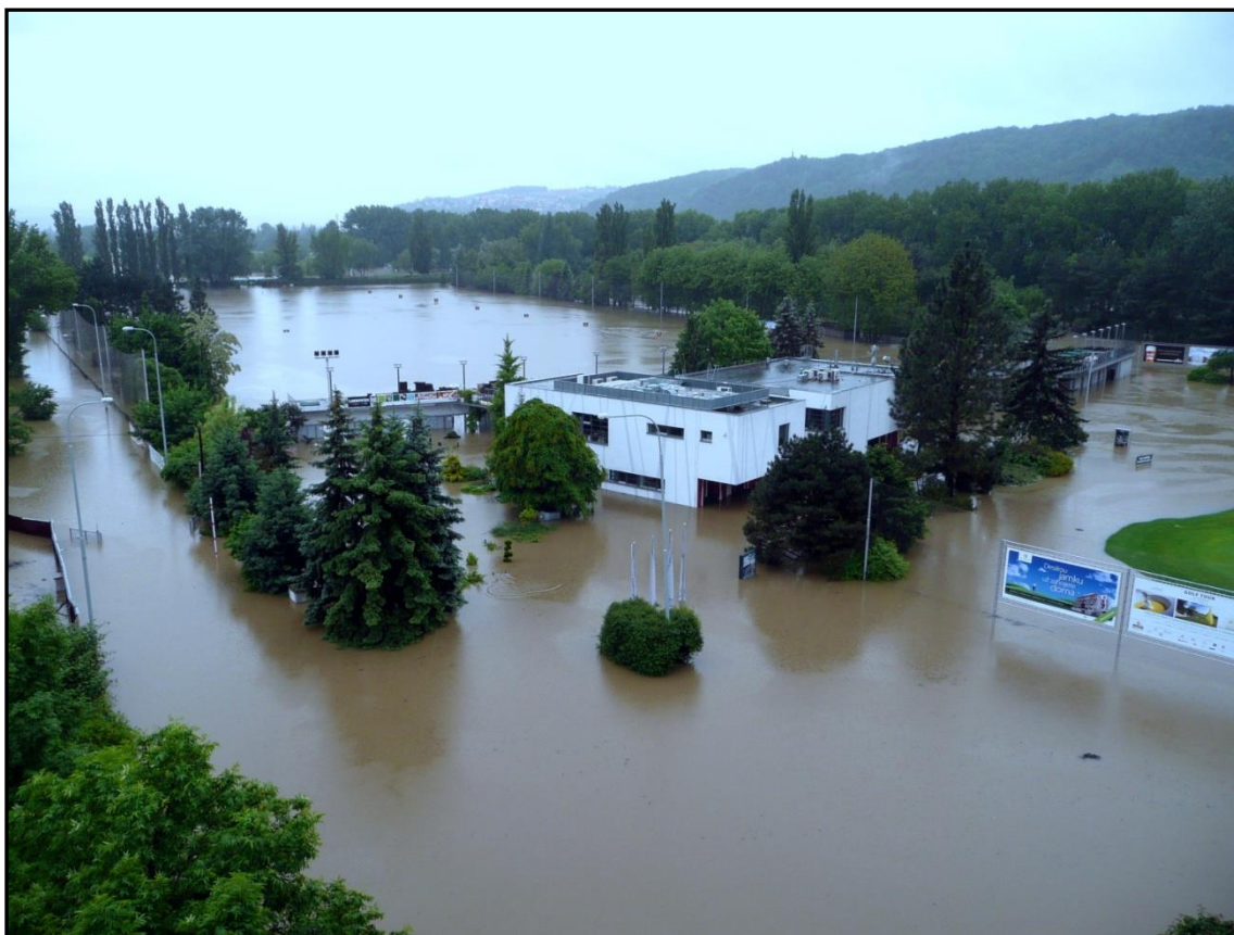
Obrázek 8: Zaplavený areál golfového hřiště v Hodkovičkách v roce 2013
