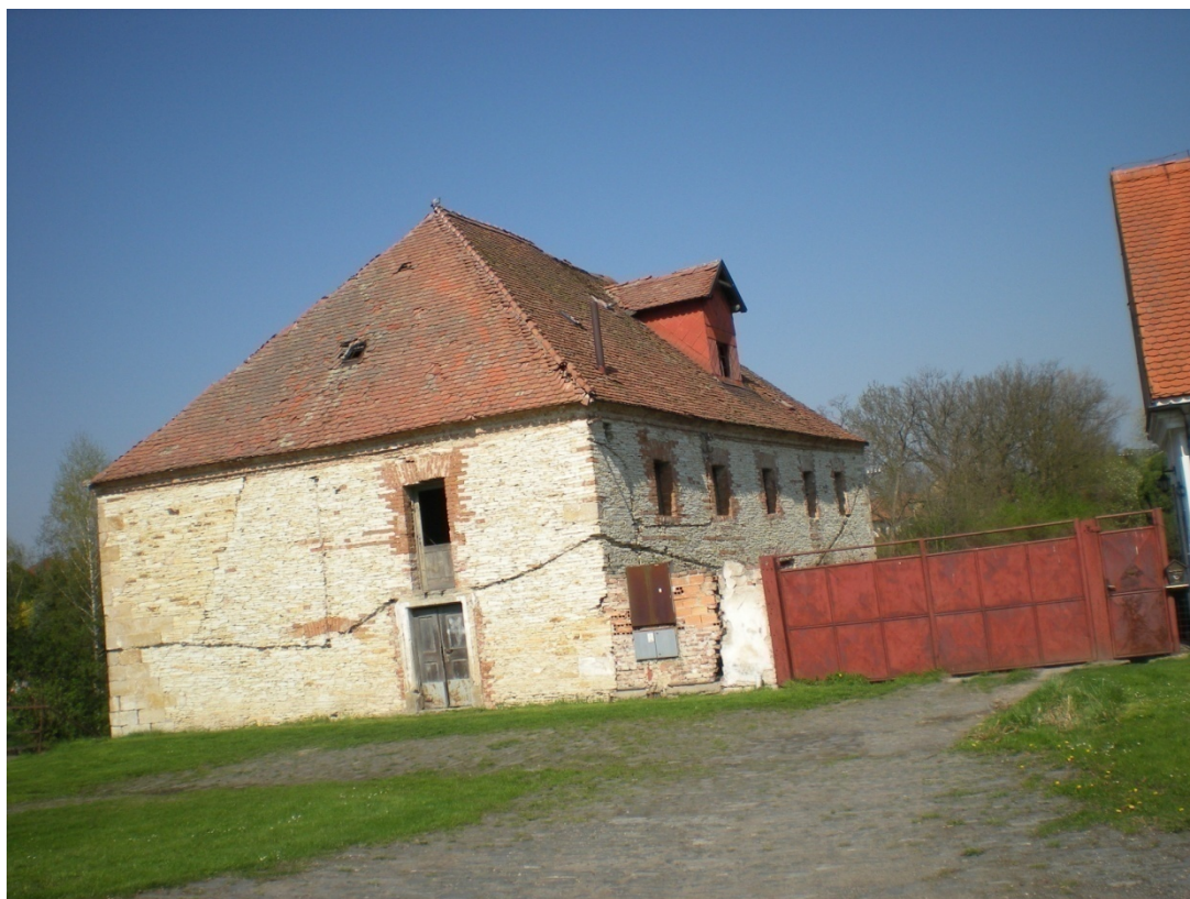
Obr. 10 Někdejší Lazarův mlýn, pohled od silnice.
