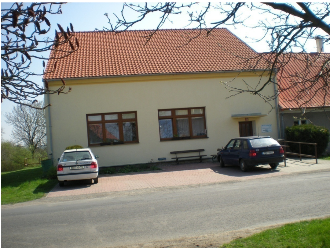
Obr. 7 Bývalá škola v Pátku, současný stav.
