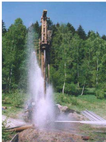
Hlubinný vrt – vrtaná studna (převzato a upraveno [137]).
