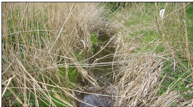
Foto č. 11: Břehy opevněné betonovou dlažbou jsou překryté vegetací (úsek RAD001)
