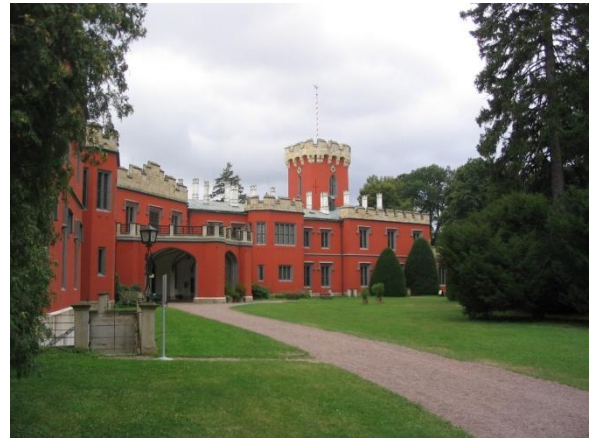
20. Hrádek u Nechanic, pohled od severovýchodu
