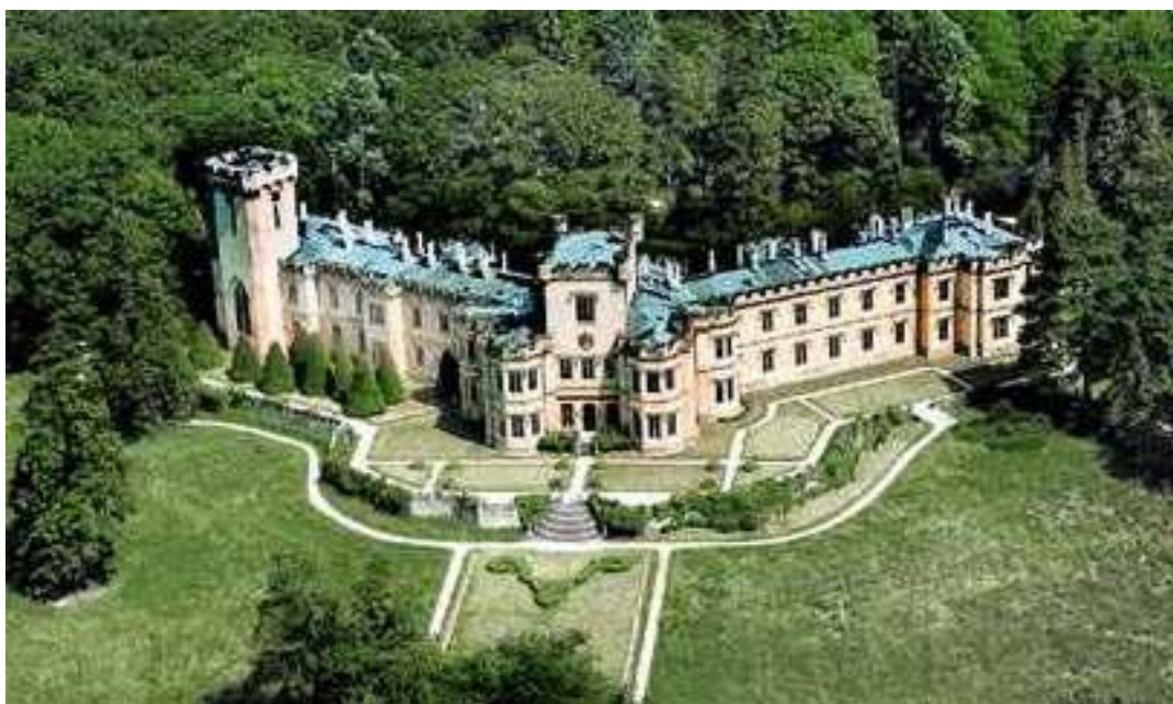
18. Hrádek u Nechanic, letecký pohled
