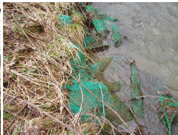
Foto 45: Detail síťoviny v patě břehu
