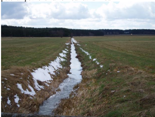
Foto 5: Napřímené koryto Barchaneckého potoka zpevněné kamennou rovnaninou
