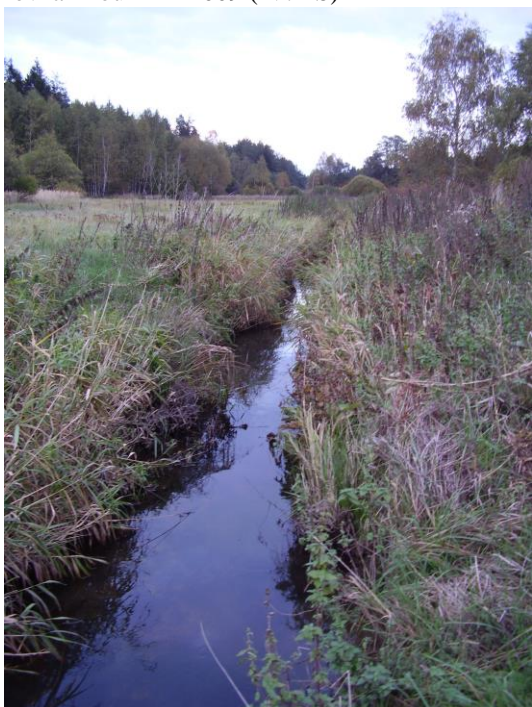
Foto 22: Zarostlé koryto Barchaneckého potoka zpevněné ve dně a březích kamennou rovnaninou - BAR009 (IV. ES)
