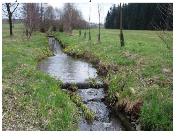
Foto 39: Dolní část revitalizovaného úseku s podstatně menším zahloubením koryta (březen, vyšší vodní stav)
