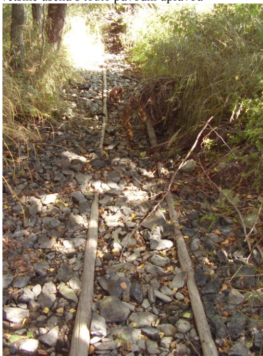
Foto 3: Zbytky úpravy kulatinou v březích a kamenným pohozen, tento stav odpovídá většině úseků s touto původní úpravou
