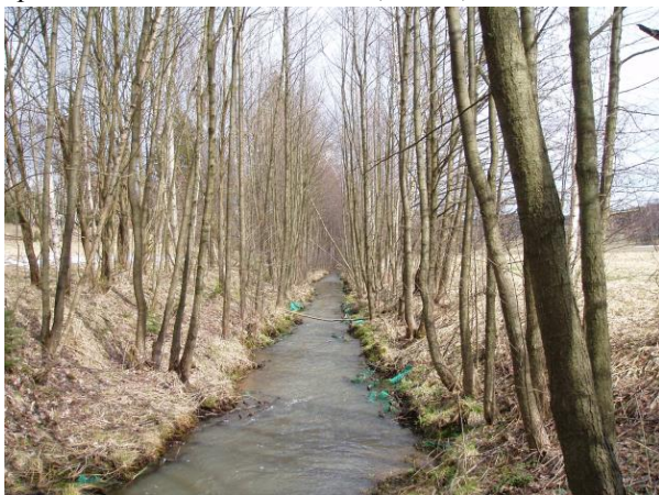
Foto 26: Kanál od bezpečnostního přelivu zahloubený až na skalní podloží, eroze břehu - BAR111 (IV. ES)
