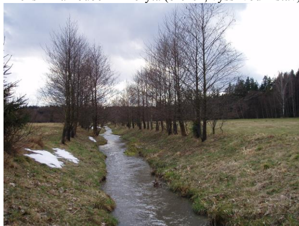
Foto 39: Dolní část revitalizovaného úseku s podstatně menším zahloubením koryta (březen, vyšší vodní stav)
