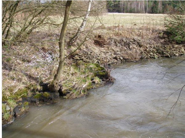
Foto 4: Vegetační tvárnice tvoří obdélníkový tvar příčného profilu koryta (Slubice před soutokem s Chrudimkou)
