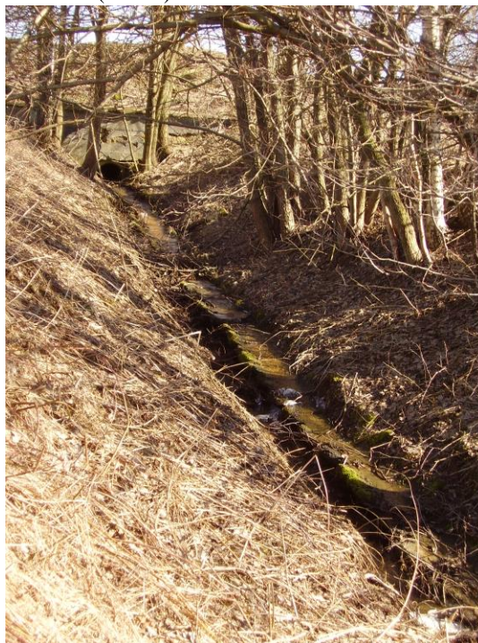
Foto 15: Umělé koryto přítoku P01, dno původně žlabovkami, dnes voda teče spíše mimo tuto úpravu - P01001 (IV.ES)
