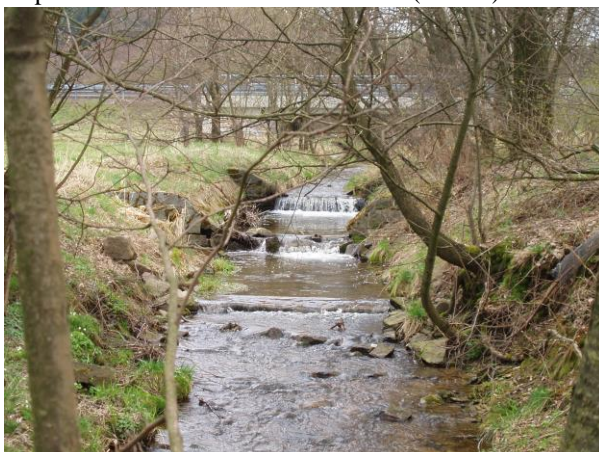
Foto 18: Revitalizovaný úsek Černého p. se dvěma stupni z lomového kamene - CER015 (III. ES)
