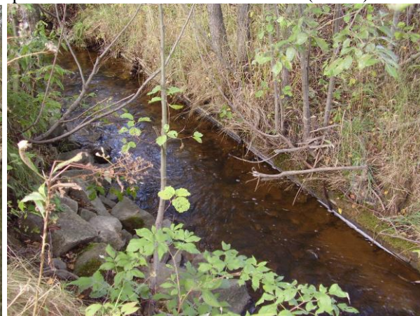
Foto 19: Zbytky kulatiny v březích a nátrž zpevněná pohozelem z hrubého kamene - CER015 (III. ES)
