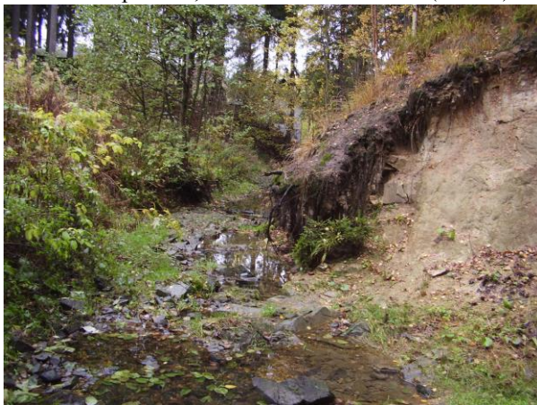
Foto 26: Kanál od bezpečnostního přelivu zahloubený až na skalní podloží, eroze břehu - BAR111 (IV. ES)
