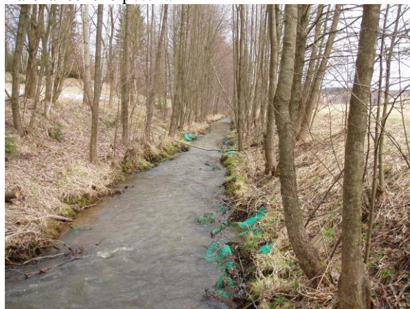
Foto 6: Úprava ze síťoviny v patách břehů Barchaneckého potoka
