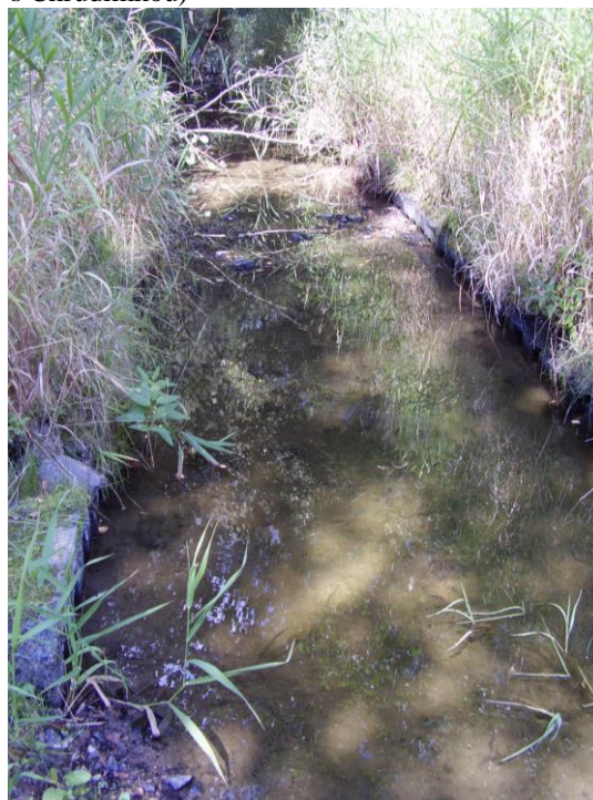
Foto 4: Vegetační tvárnice tvoří obdélníkový tvar příčného profilu koryta (Slubice před soutokem s Chrudimkou)
