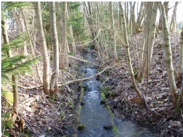
Foto 3: Zbytky úpravy kulatinou v březích a kamenným pohozen, tento stav odpovídá většině úseků s touto původní úpravou
