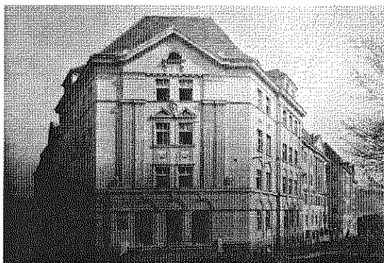
1 Komunální bytové domy – uzavřené bloky typu 1919 (vybudováno 1919) Resslova č. p. 1754, k. ú. Ústí nad Labem Fotografie, nedatováno Ausgeführte Bauten, Entwürfe und Skizzen von Architekt F. J. Arnold
