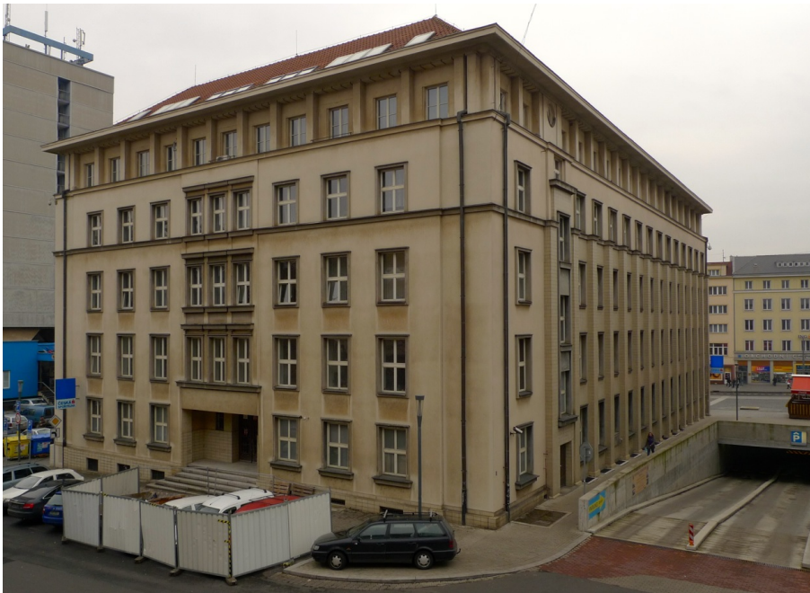
162 Franz Josef Arnold Býv. Ústecká spořitelna (vybudováno 1937–1939) Fotografie stávajícího stavu, zadní průčelí
