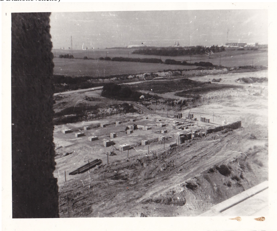
Příloha č. 8 - Fotografie pořízená během zahájení stavby sídliště (cca rok 1979) (archiv Františka Blahoňovského)
