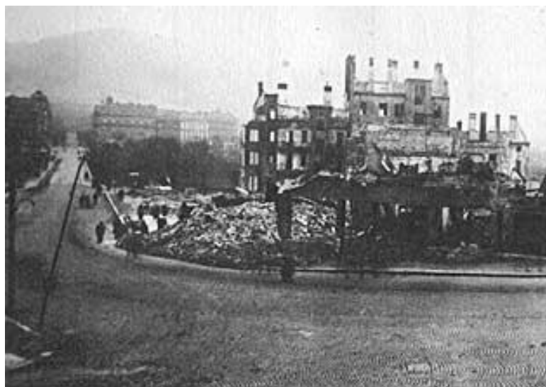
Následky po třetím bombardování 19. dubna 1945. (Pohled směrem k okresnímu soudu)
