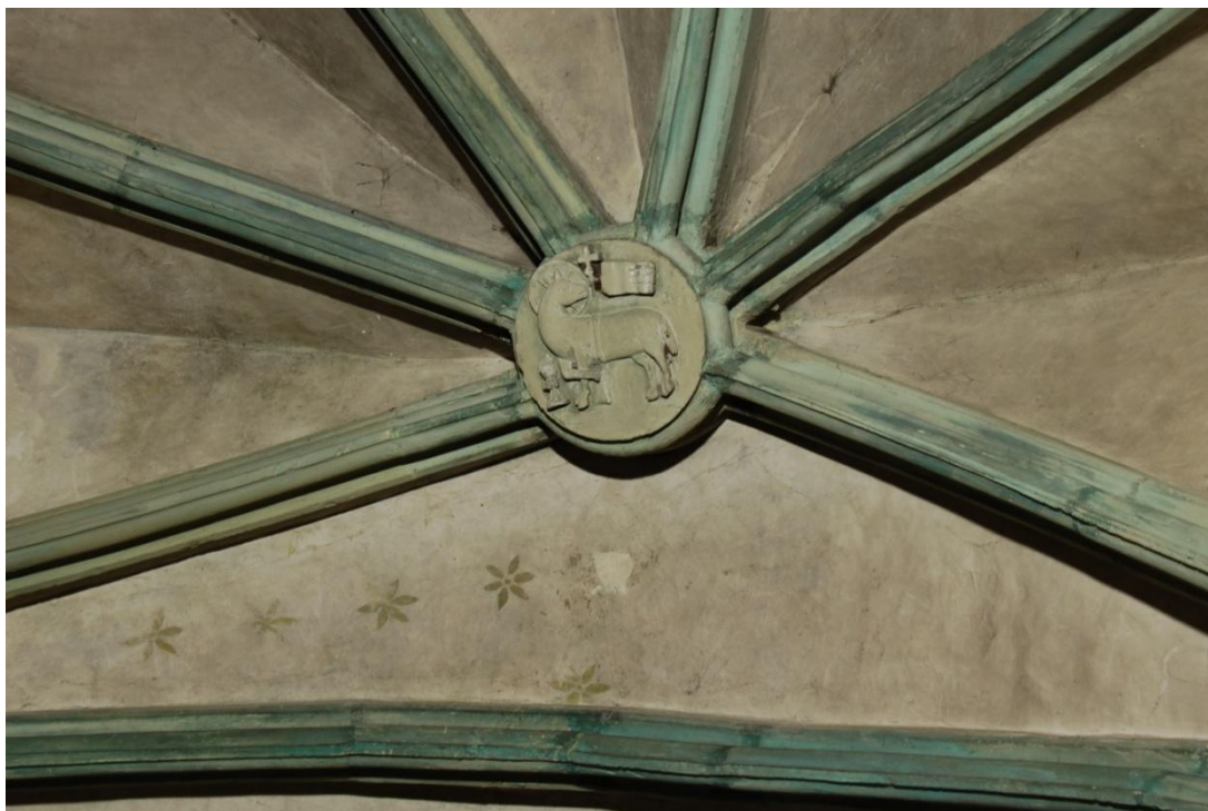
5. Klenba presbytáře s hvězdami, současný stav, Libiř, kostel sv. Jakuba Většího.
