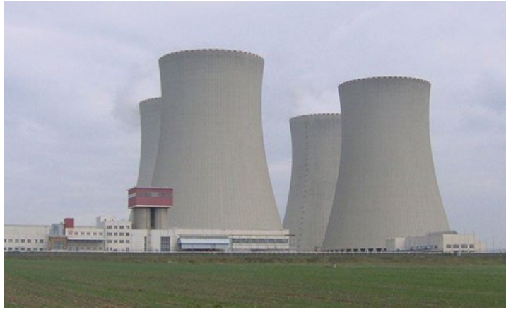
Obr. č.2. Chladičí věže jaderné elektrárny Temelín, ČR (zdroj: )
