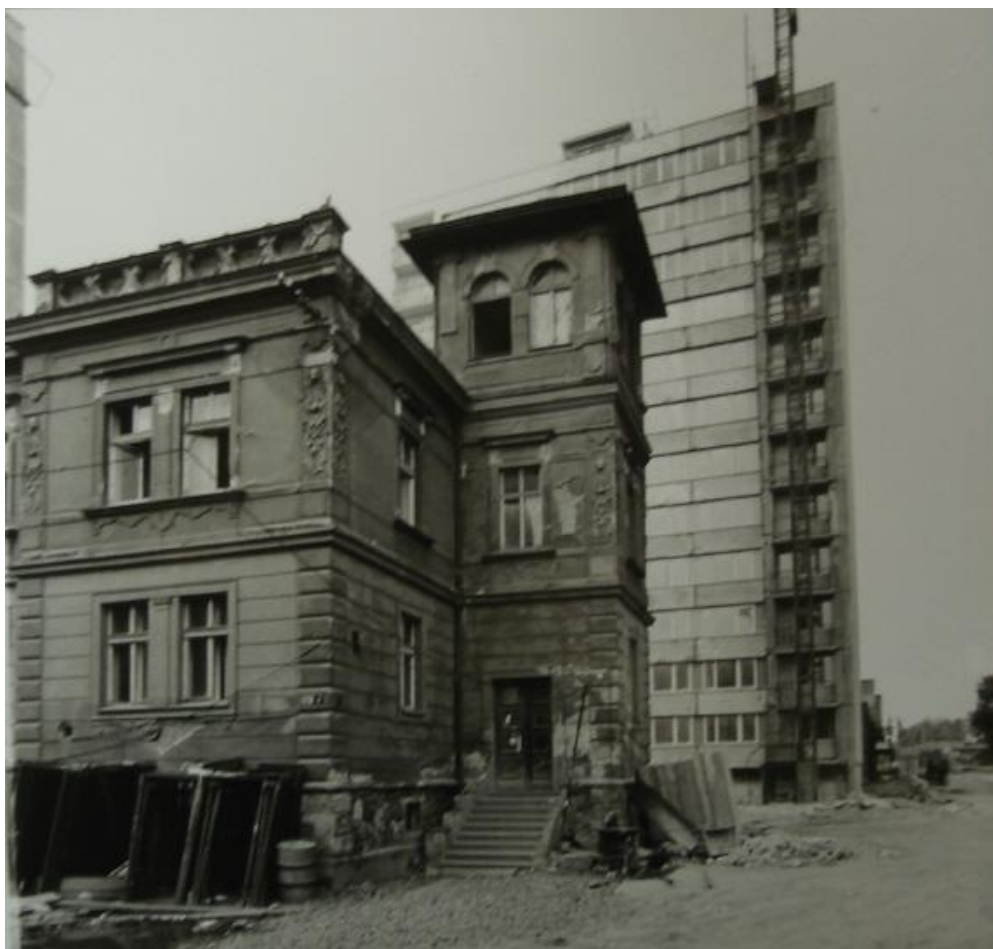
41. Jiný pohled na poslední vilu č. p. 167, v pozadí již rostoucí panelový dům
