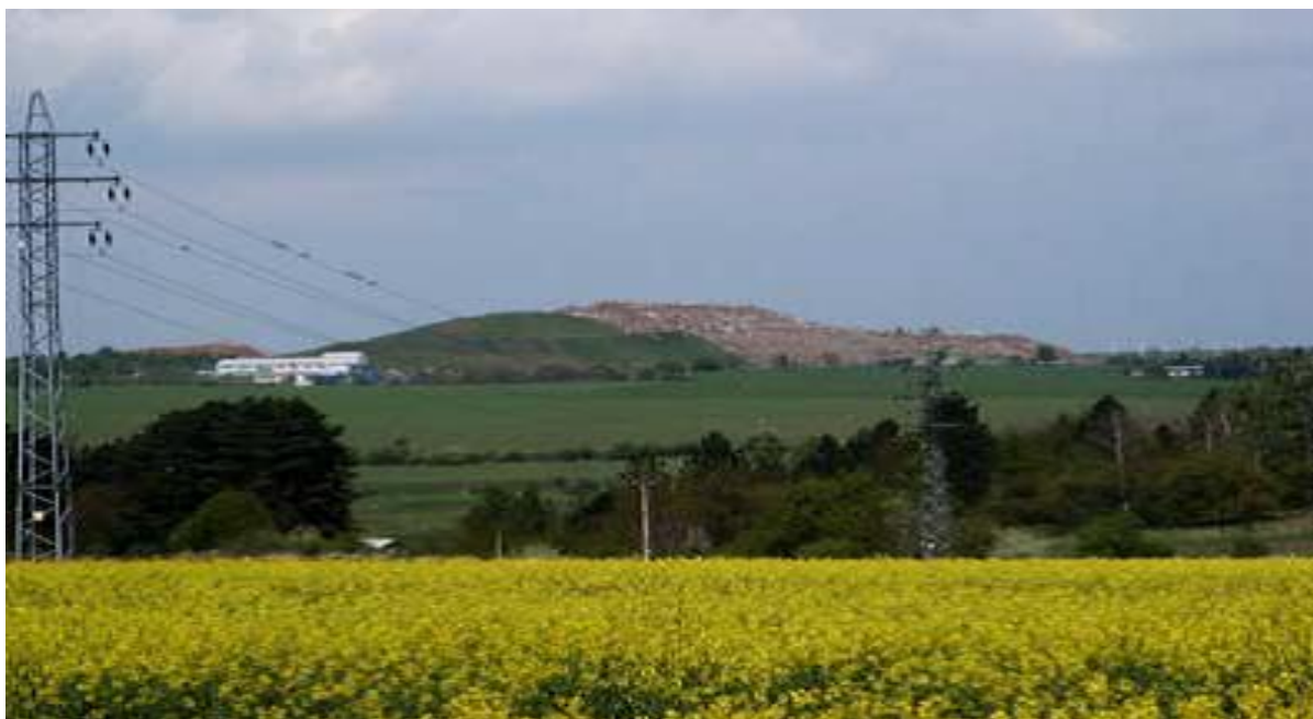
Obr. 3 Pohled na skládku od JV (Kudrna, 2013)
