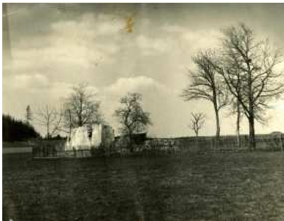
Obrázek 13 Rozvaliny vypáleného domu Josefa Vajse 240
