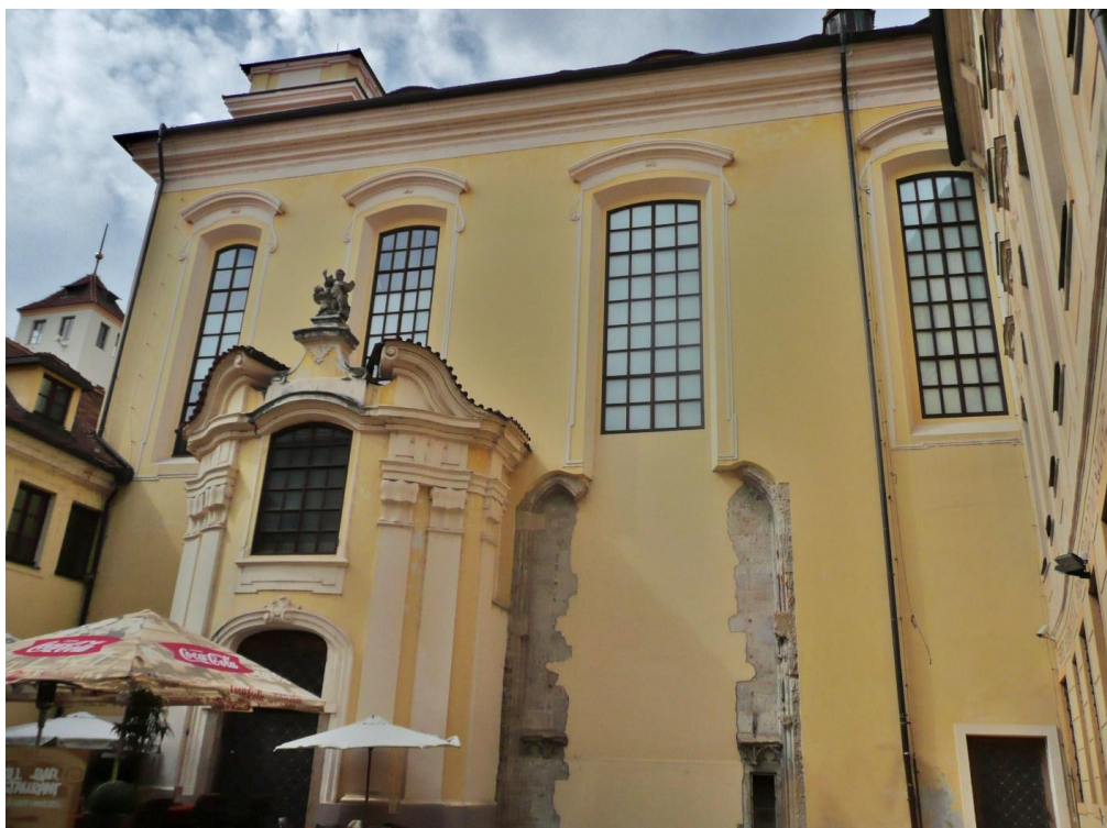
Obr. č. 7: Vchod do chrámu sv. Michala. Foto: Autorka
