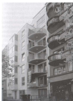
Obrázek 3: pohled od navazujícího domu
