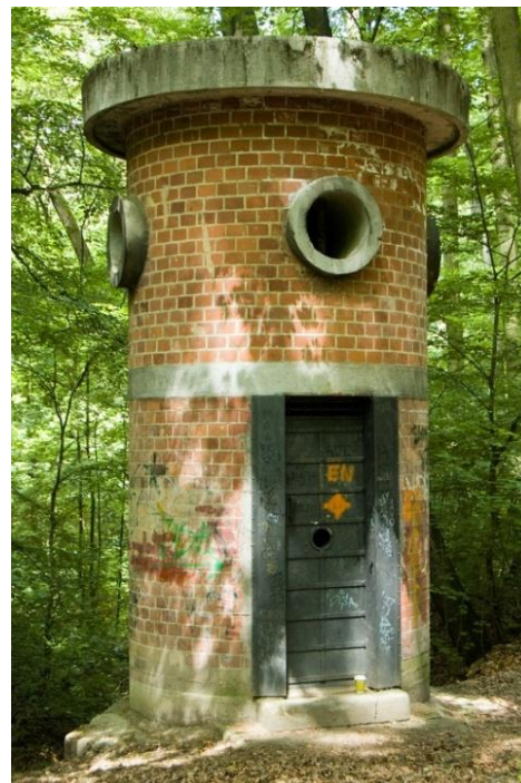
Obr. 5 Štola Světluška (originál)
