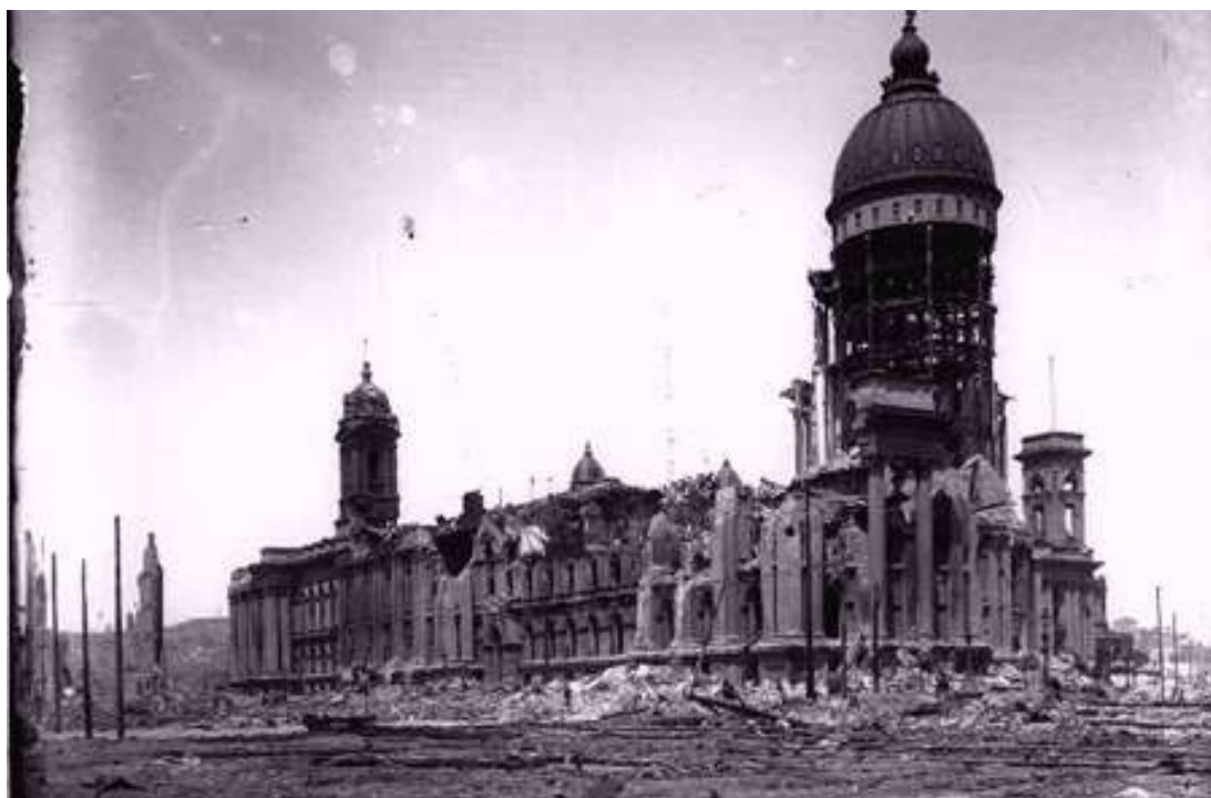
Obr.7. San Franciská mestská hala zničená zemetrasením v roku 1906 (zdroj: http://seismo.berkeley.edu ).
