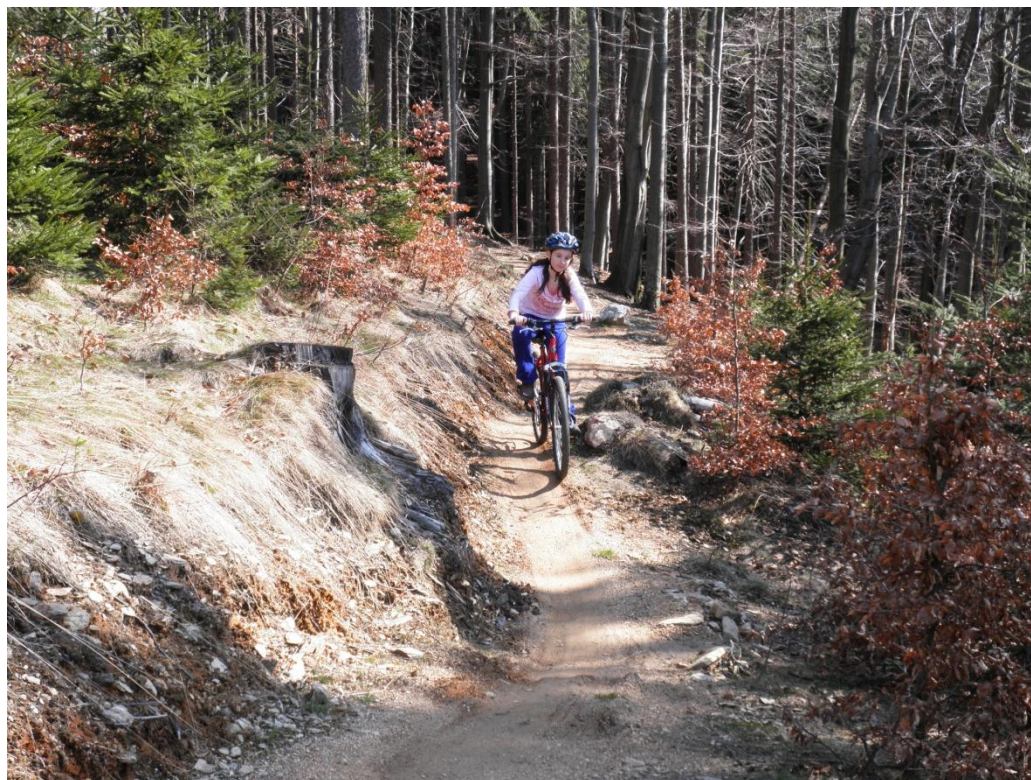
Obrázek č. 15: Dusítka z kamenů a pařezu na singltreku
