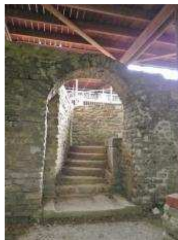
Obrázek 19: Bollendorf, pohled ze sklepních prostor na schodiště
