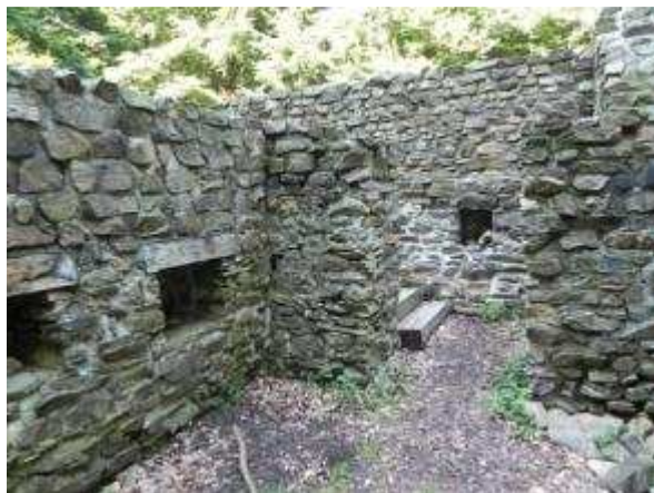
Obrázek 143: Koblenc „Am Remstecken“, sklep
