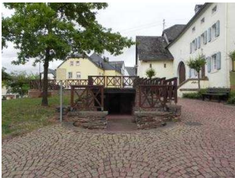
Obrázek 83: Kenn, vstup do sklepa
