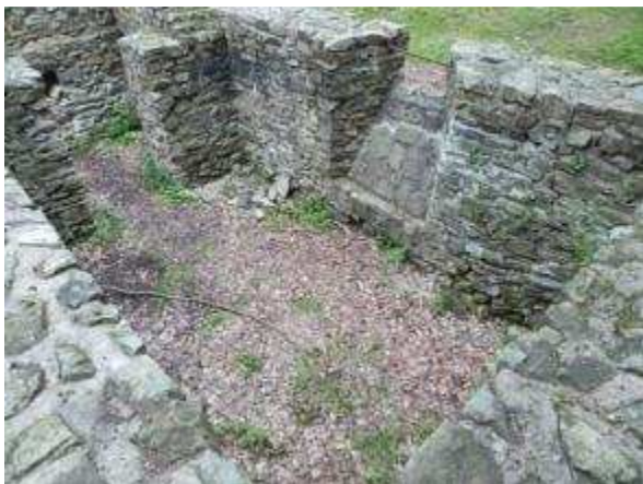
Obrázek 142: Koblenc „Am Remstecken“, sklep
