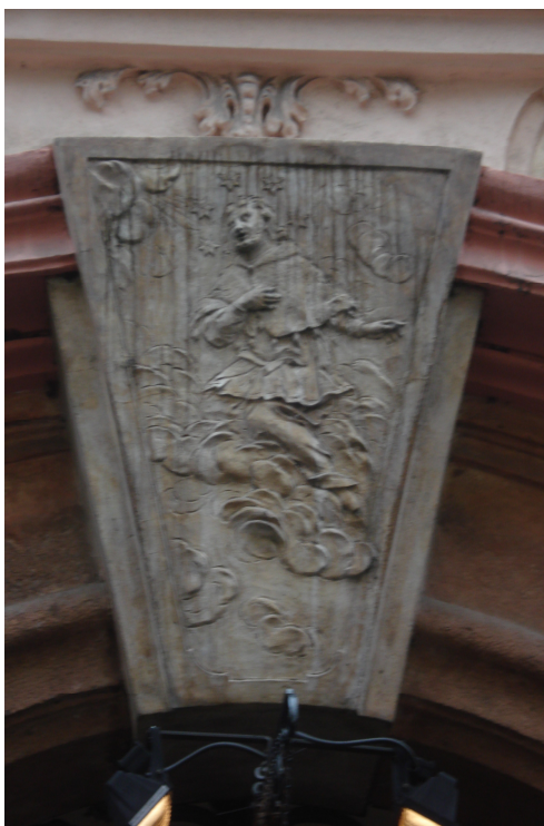
21. Detail klenáku nad vstupem domu „U sv. Jana“, Praha, Nerudova ulice
