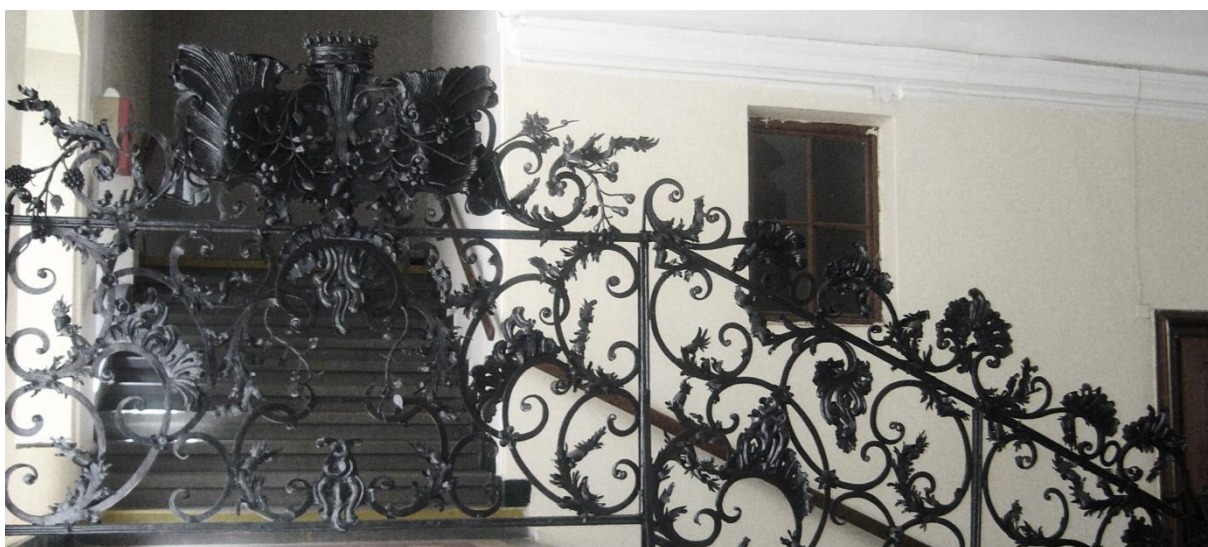
Obr. 66 Rokokové kované zábradlí se znaky rodů Chorinských z Ledské a Hodiců.
