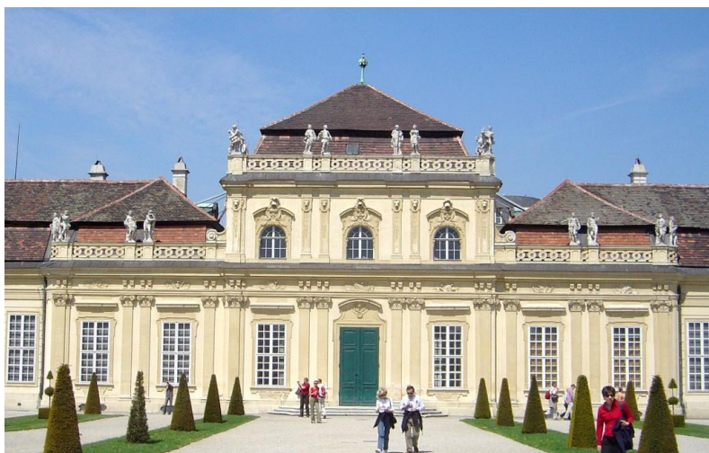
Obr. 53 Zahradní průčelí Dolního Belvederu ve Vídni.
