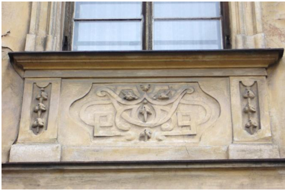
Obr. 38 Parapet oken prvního patra.
