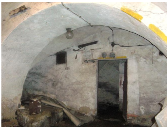
Obr. 63 Suterén pod západním křídlem paláce, pohled na sever.
