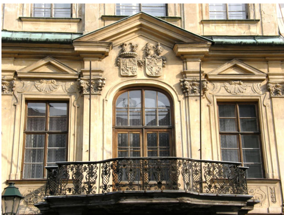
Obr. 36 Západní průčelí, detail prvního patra.
