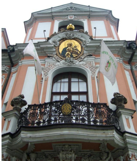
Obr. 47 Sobkův palác v Opavě, detail balkónu.
