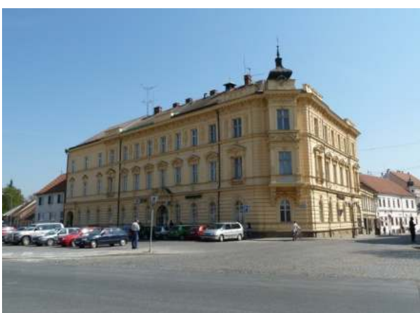
16. Vojtěch Dvořák, Karel Welzl, dům Záložny v Ivančicích, současný stav
