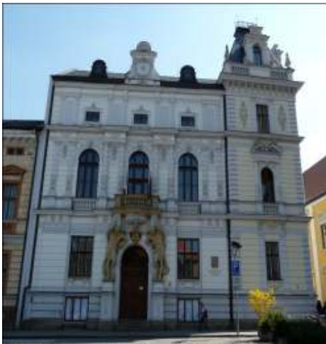
19. Vojtěch Dvořák, Karel Welzl: radnice v Uherském Hradišti, současný stav
