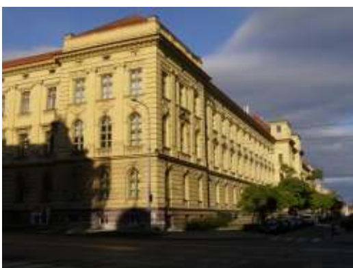
32. Vojtěch Dvořák, Karel Welzl, (Grueber): školní budova v Sokolské ulici, Brno, pohled z ulice Veveří, 1899-1901
