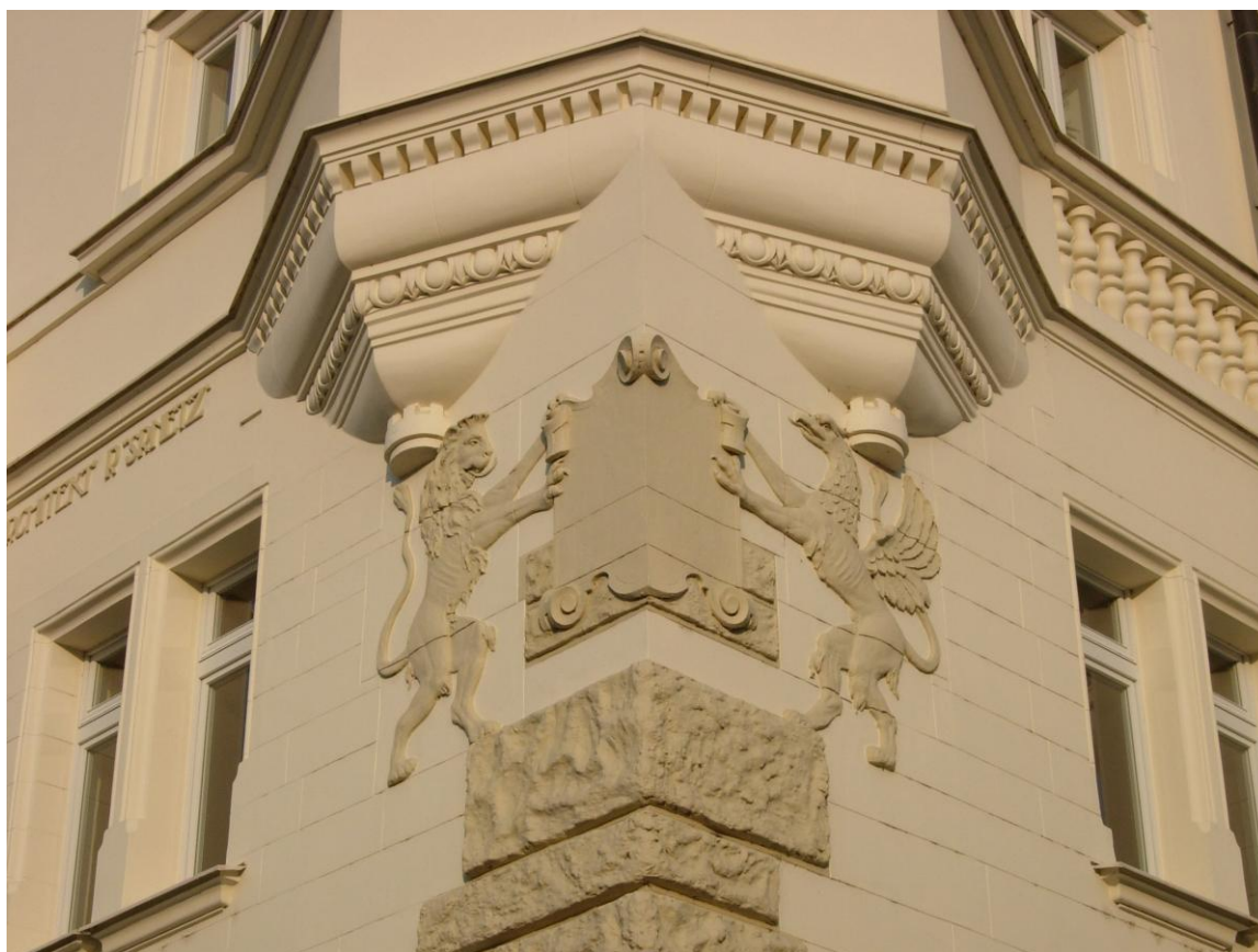
Obr. 14: Rudolf Smetz: Štukový reliéf lva a gryfa jako štítonošů pod nárožním arkýřem na budově tzv. Nového Schmetterhausu/Hlásky (1901-1903).
