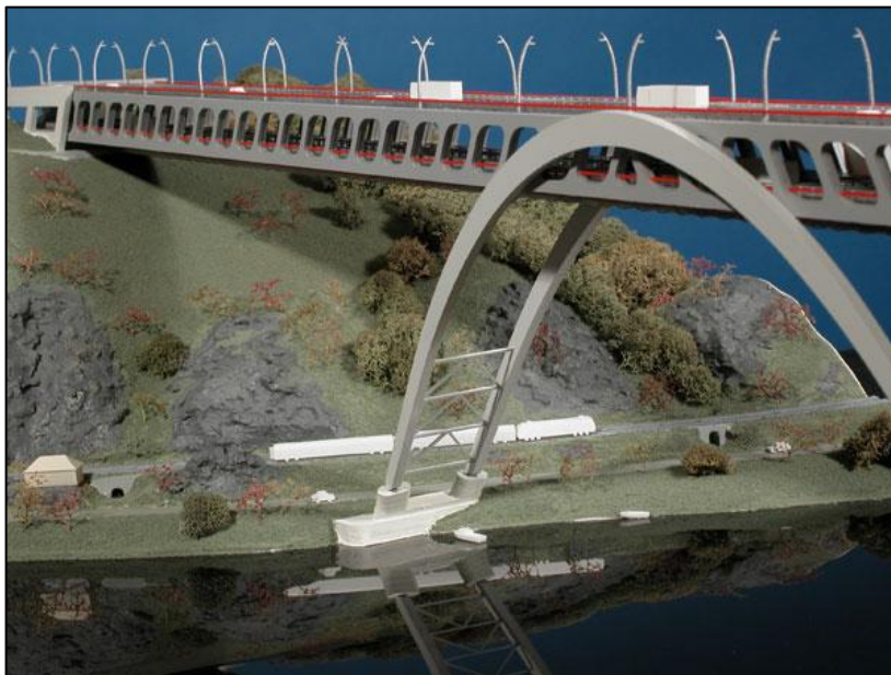
Obr. 3: Detail založení patek na levém břehu (Rotter, 2009)
