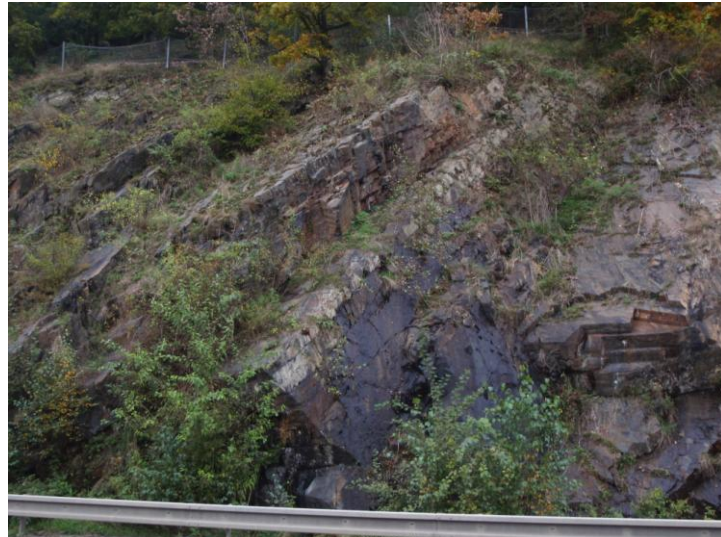
OBRÁZEK 102: POHLED NA ČÁST SKALNÍHO ODŘEZU, TMAVÁ MÍSTA UKAZUJÍ MÍSTA VÝVĚRŮ PODZEMNÍ VODY, V TOMTO MÍSTĚ BYLO ZA SVODIDLY NALEZENO NEJVÍCE ÚLOMKŮ. ARCHIV AUTORA
