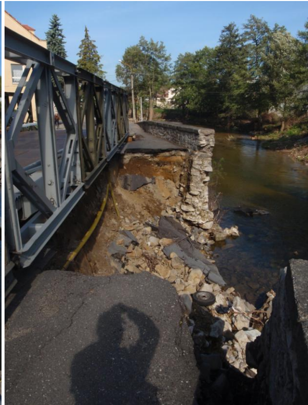
OBRÁZEK 99: ZBORCENÁ OPĚRNÁ ZEĎ V RASPENAVĚ.
