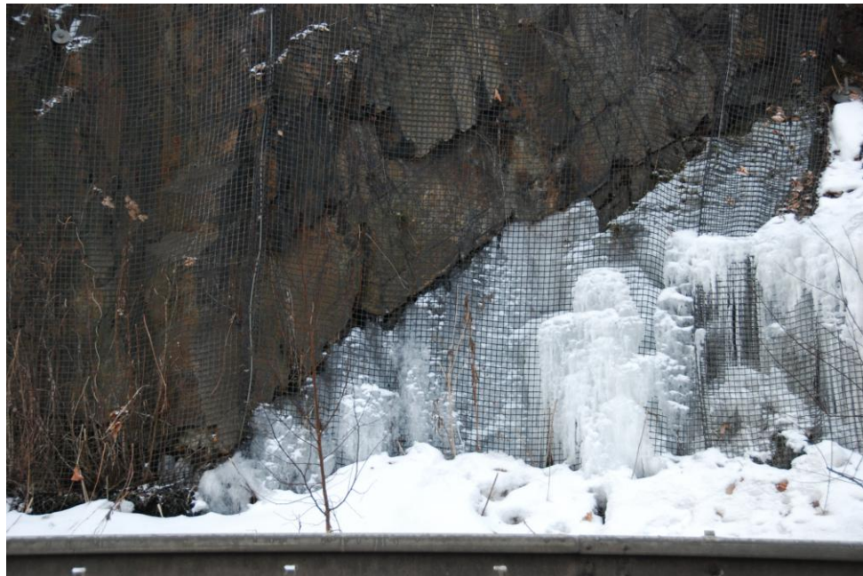
OBRÁZEK 104: UKÁZKA JEDNÉ Z PUKLIN, Z NÍŽ NA STĚNĚ VYTĚKÁ VODA ( 4.1.2011)
