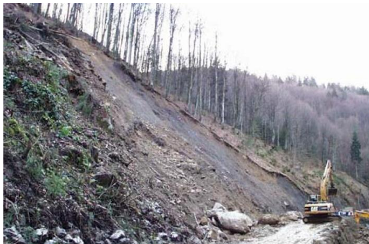
OBRÁZEK 20: JEDEN Z PŘÍVALOVÝCH PROUDŮ, VZNIKLÝCH PO ODTĚŽENÍ PATY SVAHU. ARBANAS ET AL., 2006
