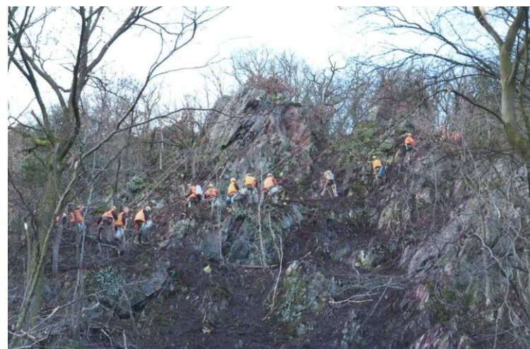
OBRÁZEK 32: POHLED NA ZŘÍCENOU SKALNÍ STĚNU BĚHEM JEJÍHO OČIŠŤOVÁNÍ. RŮŽIČKA, 2011
