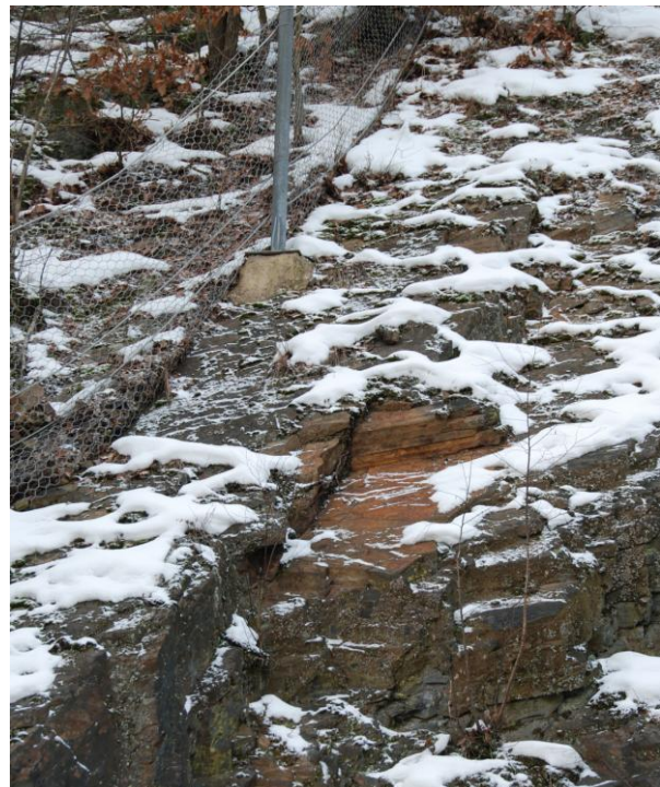
OBRÁZEK 105: UKÁZKA JEDNOHO Z MENŠÍCH VYJETÍ BLOKŮ PODÉL VRSTEVNATOSTI ( 4.1.2011)
