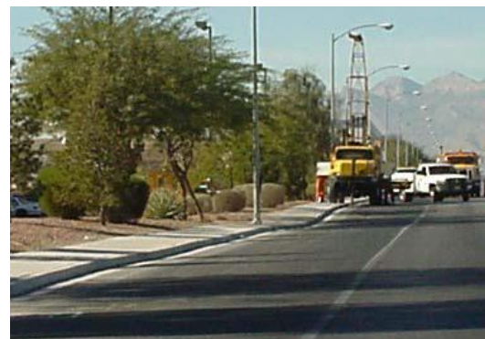
OBRÁZEK 53: FOTOGRAFIE POSTIŽENÉHO ÚSEKU A VZNIKLÝCH DEFORMACÍ. BOOMHOWER, 2003.
