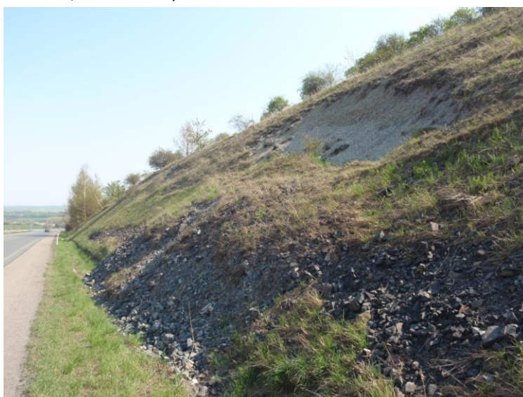
OBRÁZEK 95: POHLED NA NEJVĚTŠÍ SESUV V ZÁŘEZU. 19.4.2011
