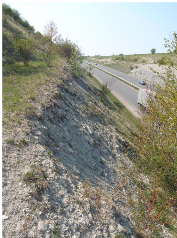
OBRÁZEK 94: DRUHÝ TYP SVAHOVÝCH DEFORMACÍ V ZÁŘEZU, 19.4.2011
