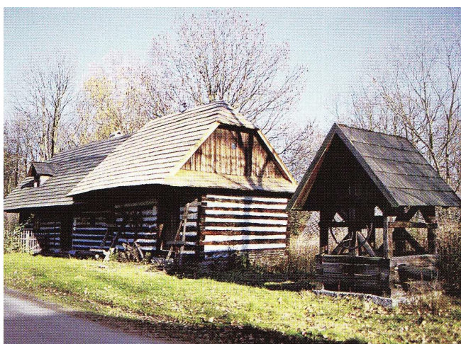
Obr. č. 13: Roubená truhlárna v Možděnici
