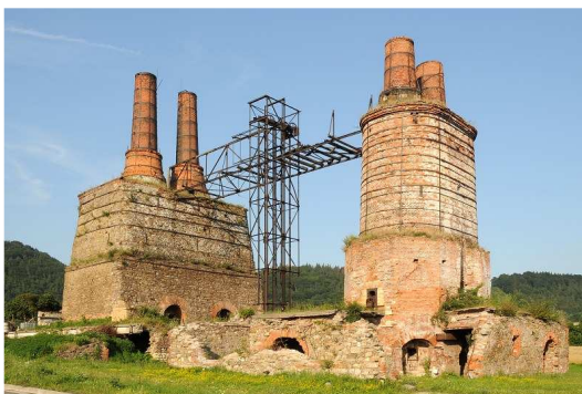
Obr. č. 9: Berlova Vápenka před rekonstrukcí
