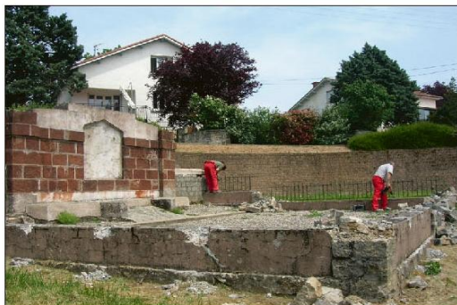
Démolition du monument provisoire qui datait de 1950.
