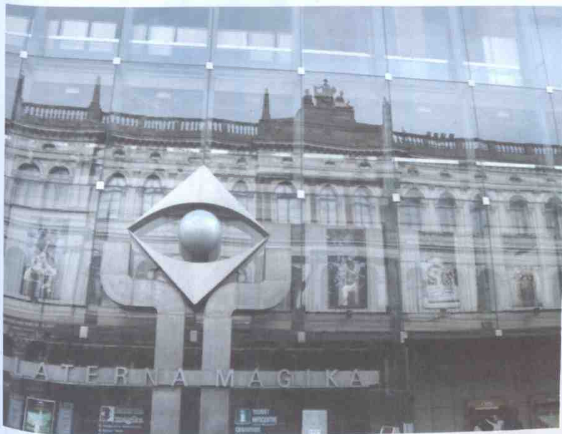
obr. č. 29 Stavba Laterny magiky zrcadlí původní zástavbu a rozehrávající tak zajímavou hru mezi novým a starým, mezi současným a minulým
