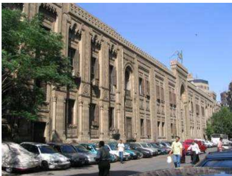
4. Budova Wizārat al-'awqāf (Ministerstvo waqfů), Káhira, 1898-1929, architekt Maḥmūd Faḥmī. Neoislámský styl.
