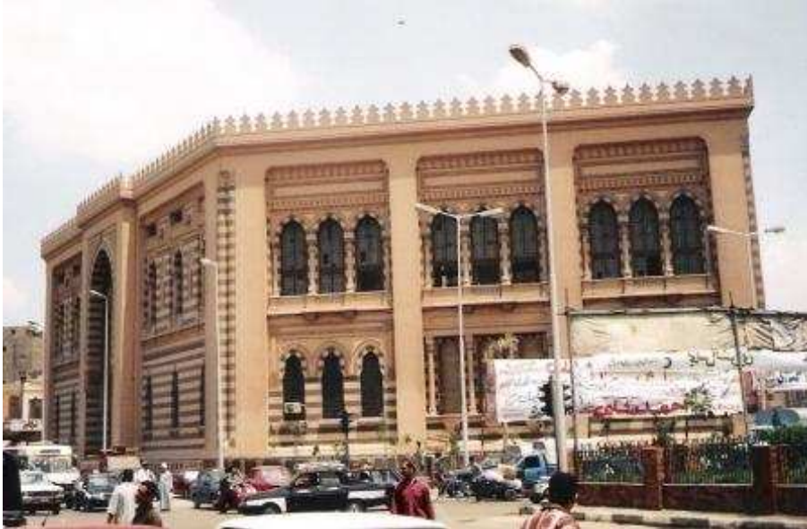
1. Budova Dār al-kutub , Káhira, 1870, architekt Alfonso Maniscalco (dnes sídlo Muzea islámského umění). Neoislámský styl inspirovaný mamlúckou architekturou.
