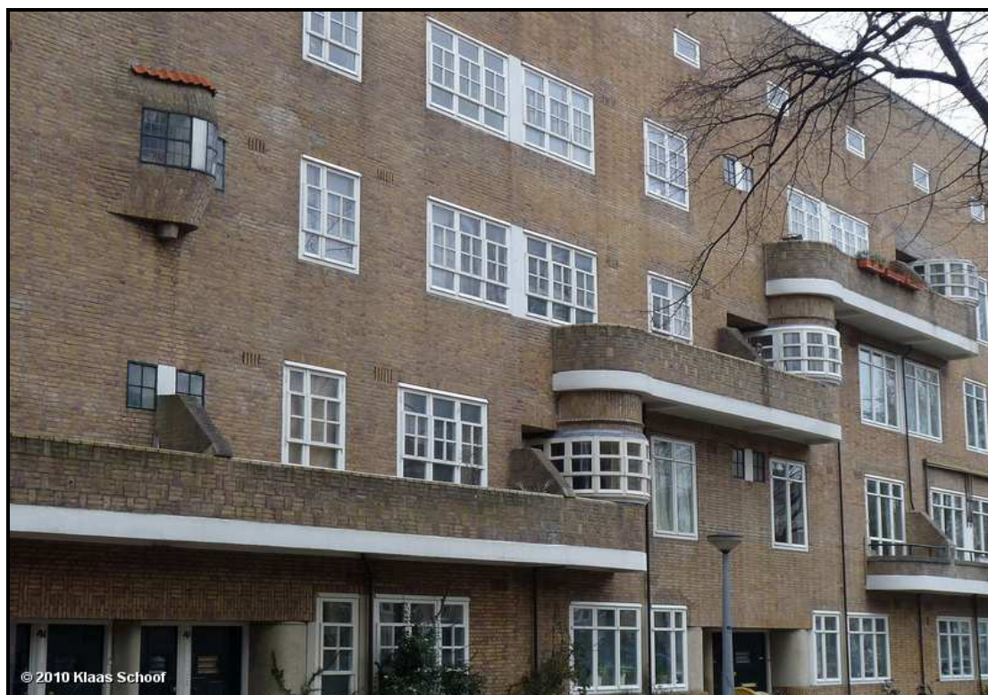
Obrázek 27 - Detail fasády z jednoho domu realizovaného při Jižním plánu ve 20. letech převzato z (64)
