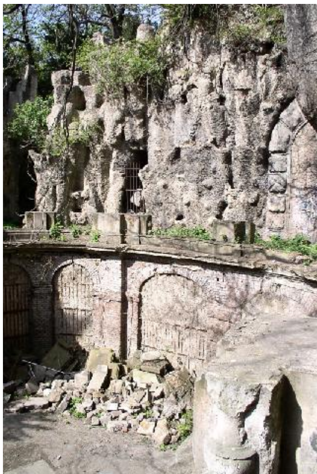
Obr. č. 11: Gröbovka- grotta před rekonstrukcí. (Grébovka, 2007)
