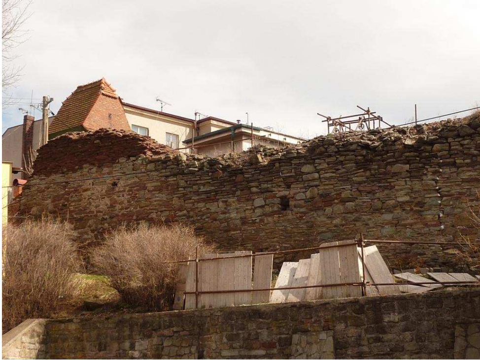
Obrázek 18: Broumov, autenticky dochovaný úsek městského opevnění. Stav v roce 2010.
