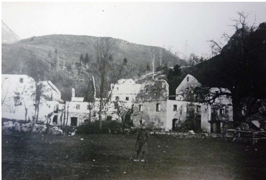
Příloha č. 2: Pohled na zbořené domy cestou na frontu.
