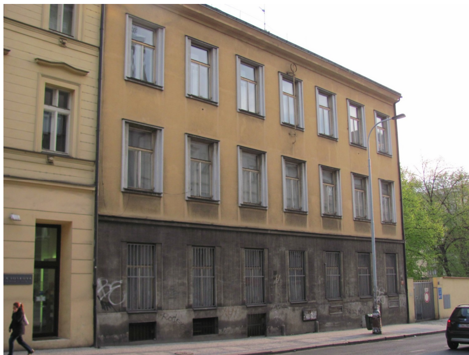
obr. 26 – boční pohled na budovu bývalé Vyšší ošetrovatelské školy, otevřené v roce 1946; nyní zde sídlí Foniatriká klinika VFN; Žitná ul., Praha 2 (vlastní foto, 19. 04. 2012)
