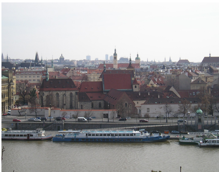
obr. 4 – areál bývalého kláštera sv. Kláry se špitálem sv. Františka, dnes ve správě Národní galerie Praha; pohled z Letenských sadů (vlastní foto, 10. 04. 2010)
