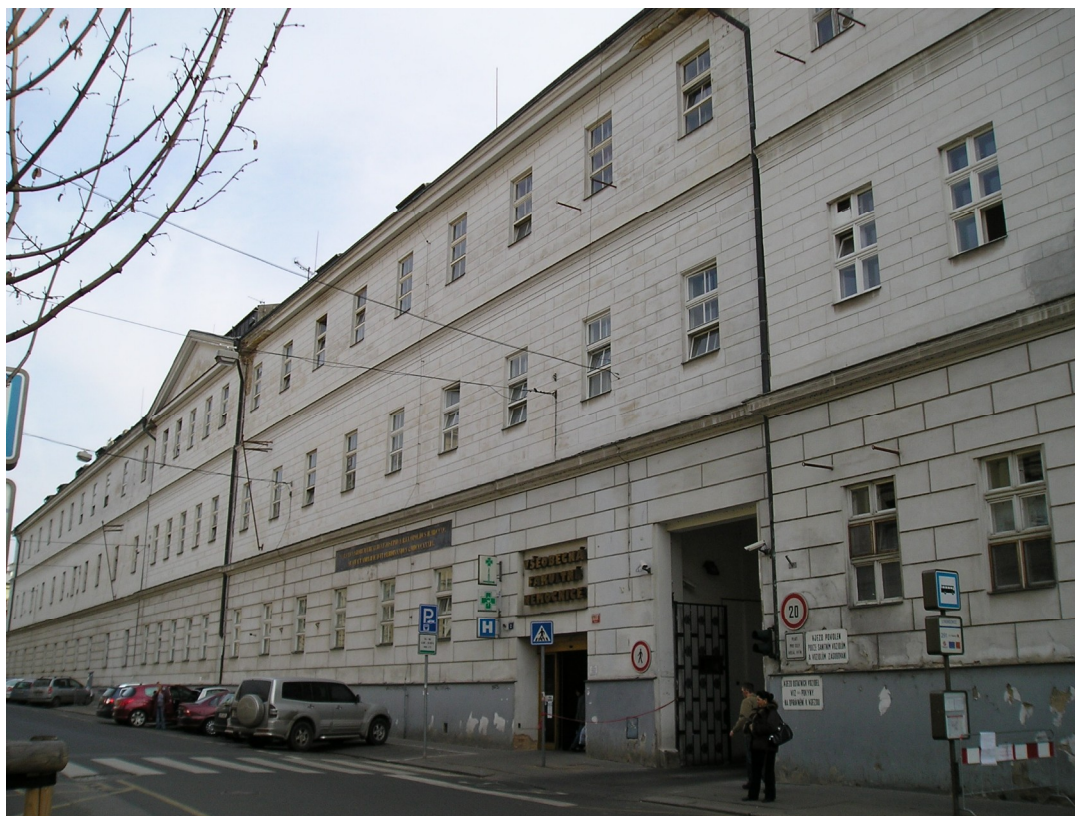
obr. 15 – budova Všeobecné nemocnice, dnešní Všeobecné fakultní nemocnice, otevřené roku 1790; ul. U Nemocnice, Praha 2 (vlastní foto, 16. 04. 2010)
