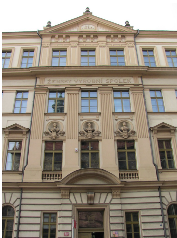
obr. 20 – průčelí budovy Ženského národního spolku, nyní Československá obchodní akademie; Resslova ul., Praha 2 (vlastní foto, 19. 04. 2012)
