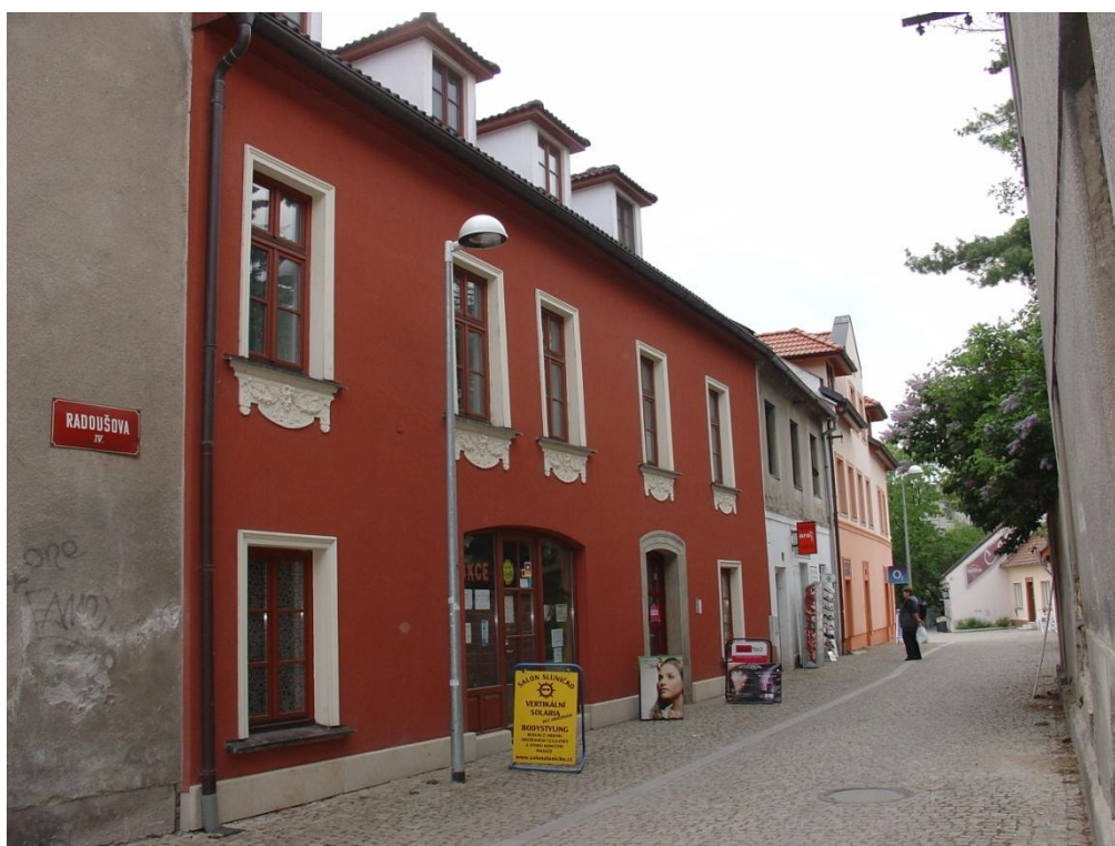
48: Dům čp. 14/IV. v Radoušově ulici, foto autor
