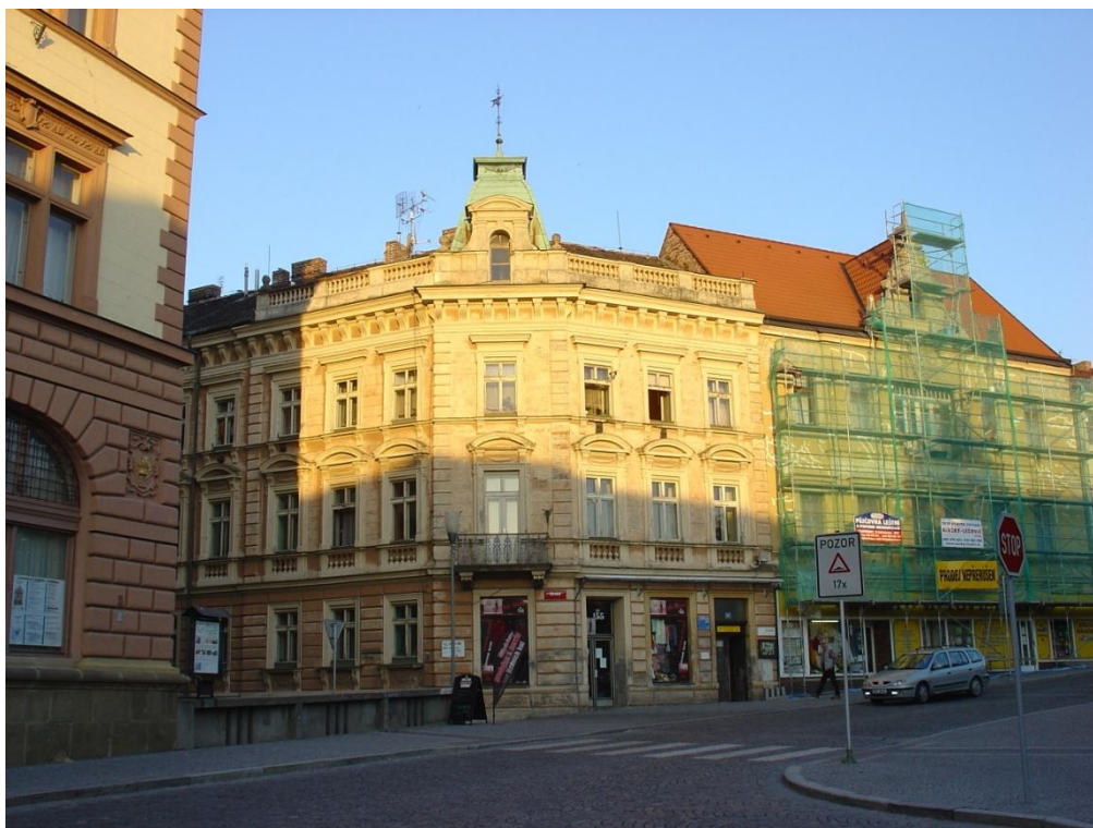
56: Dům Adlerových v Široké ulici čp. 87/IV. Foto autor
