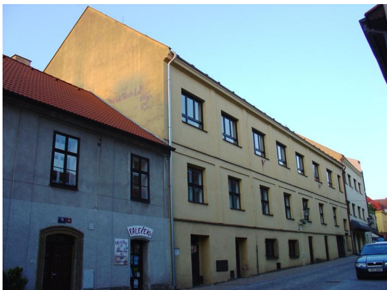
12: Současná podoba domu čp. 35/I. ve Filištiné ulici, foto autor
