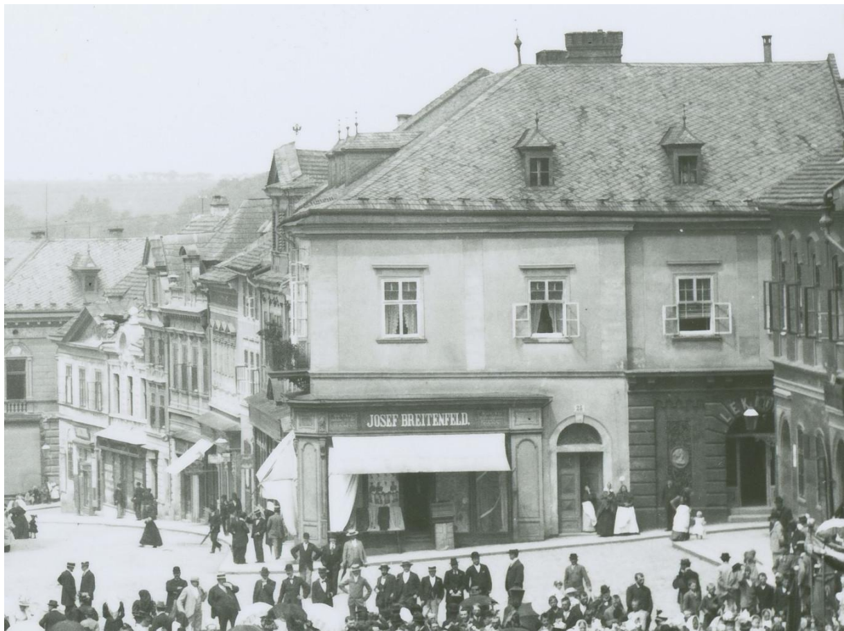
35: Dům čp. 129/I. s obchodem Josefa Breitenfelda. Výřez z většího snímku z archivu RM Chrudim
