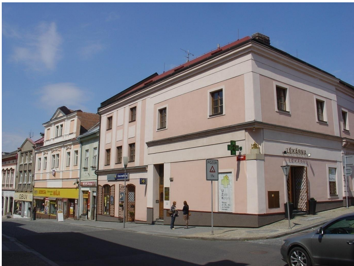
34: Domy čp. 129/I. a 130/I. na rohu Široké ulice Resslerova náměstí, foto autor
