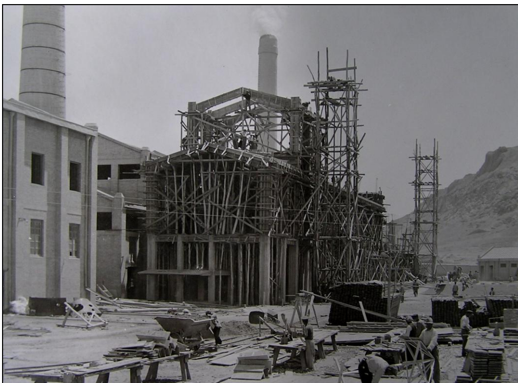
Obr. 15 Škodovy závody – stavba cementárny v Teheránu
