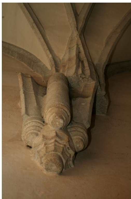
Rožmberk nad Vltavou, sv. Mikuláš – klenba kněžiště, Hans Getzinger, dokončeno 1525 (datace v závěru). Detail předělu mezi první a druhou stavební etapou na jižní stěně.
