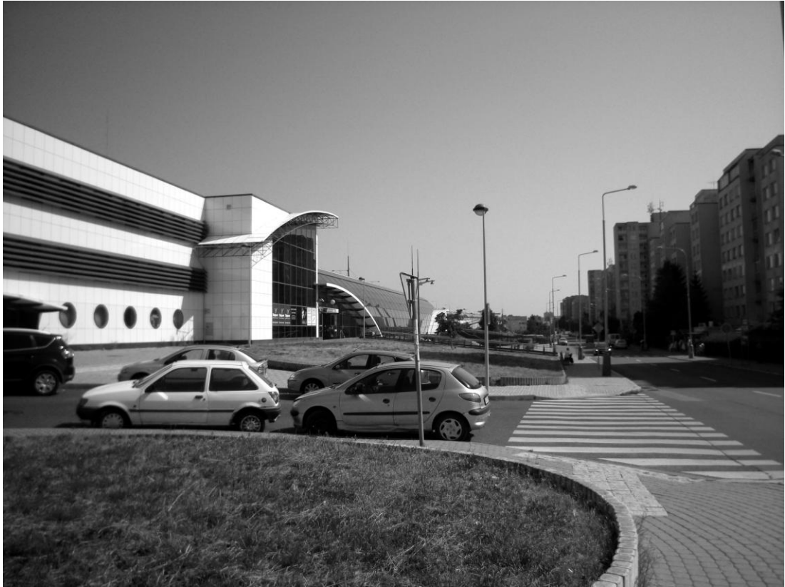
Obr. 23 Pohled na stanici metra Rajska Zahrada. Naproti sídliště Černý Most I. Foto archiv autorky.
