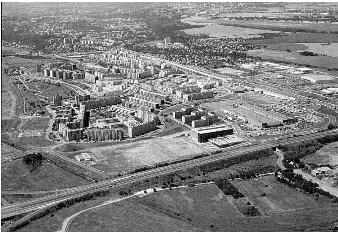
Obr. 12 Černý Most II + Centrum Černý Most od východu. Dostupné na http://praha14.cz/MC/letecky.html .
