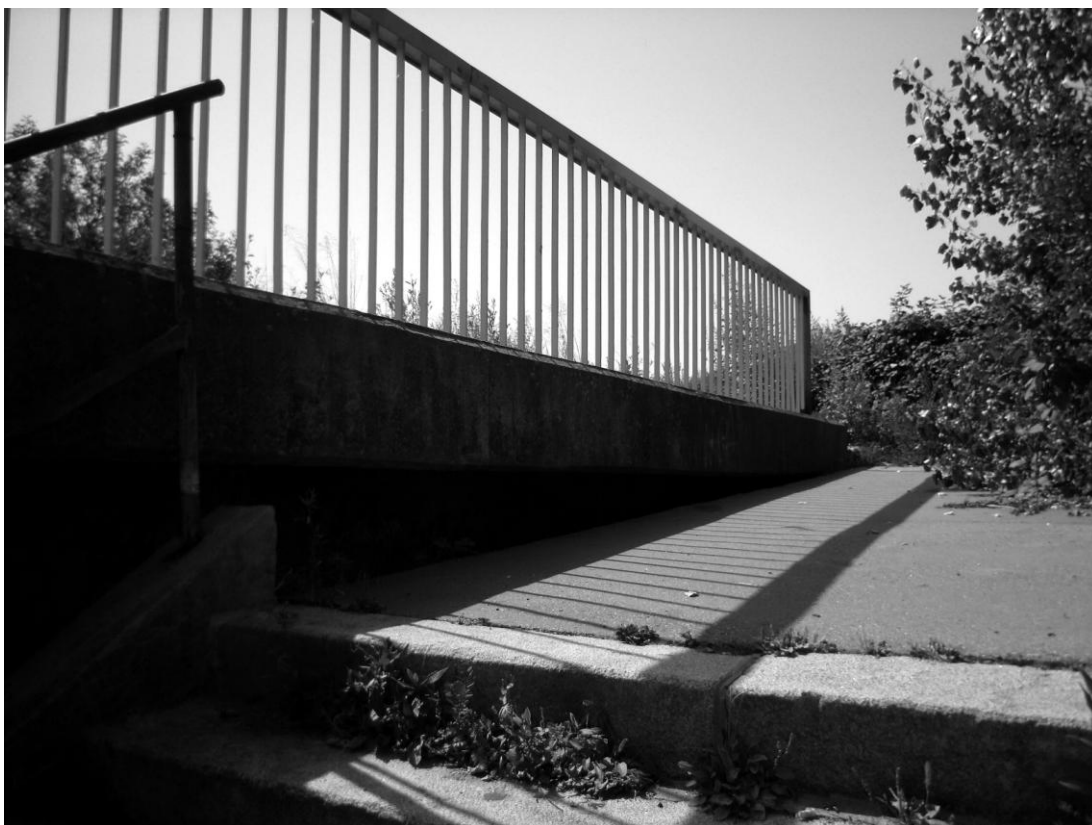
Obr. 31 Plynulost pěšího provozu je problematická. Foto archiv autorky.
