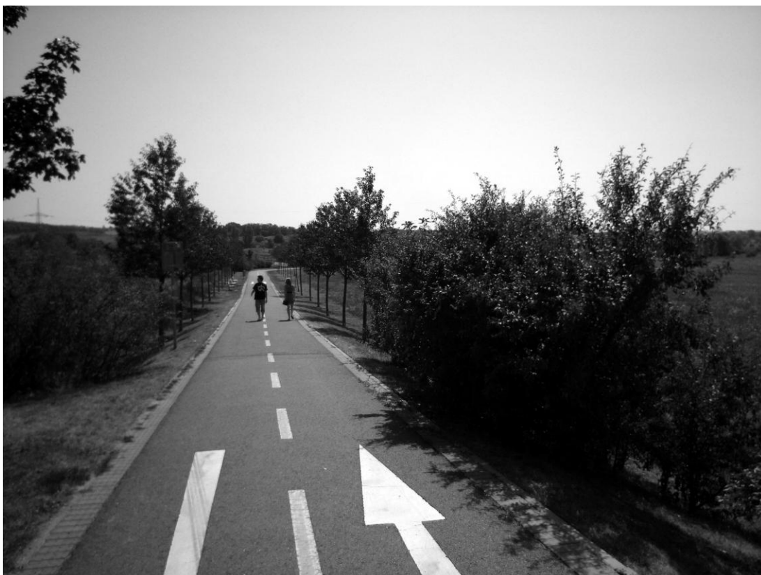
Obra. 41 Míříme od Černého Mostu. Foto archiv autorky.
