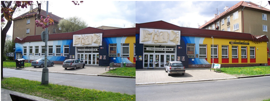
Obr. č. 10 a 11: Budova Strašnického divadla, pohled z parku
