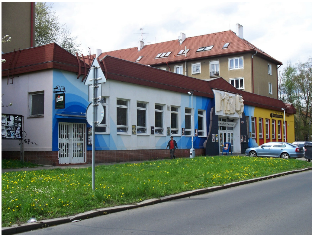
Obr. č. 18: Pohled na budovu ze směru od autobusové zastávky
