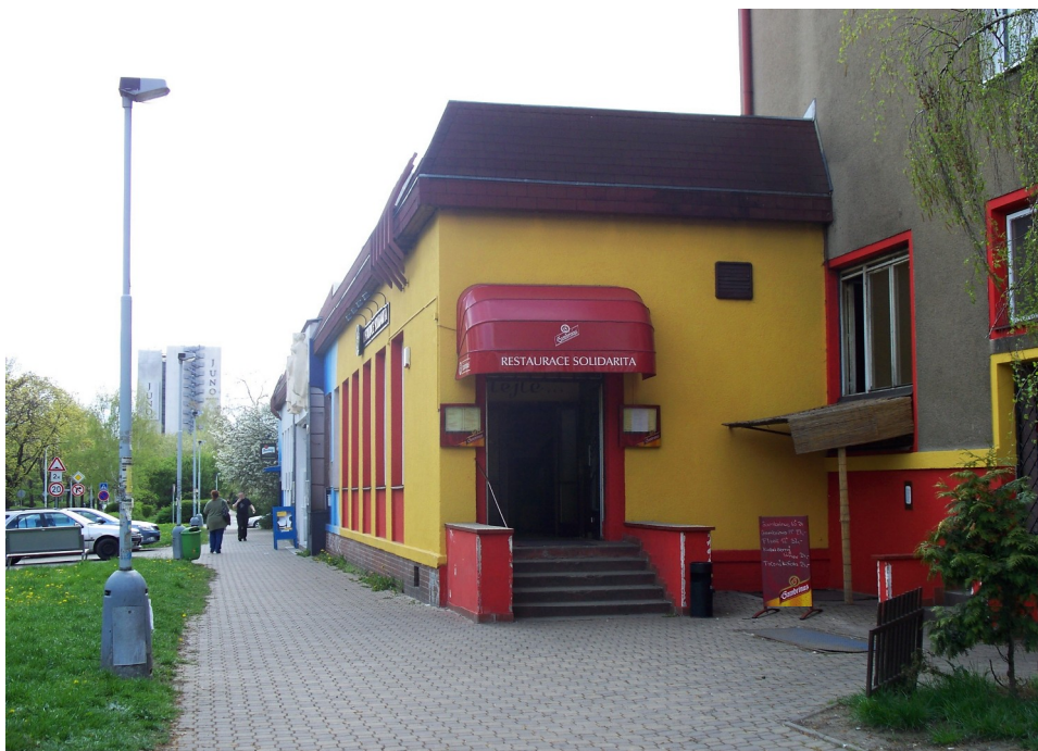
Obr. č. 5: Pohled na budovu ze směru od hlavní ulice
