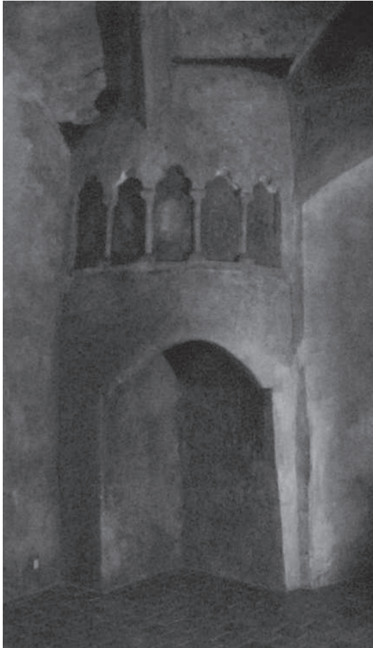
20. Jindřichův Hradec, krb v patře starého paláce
