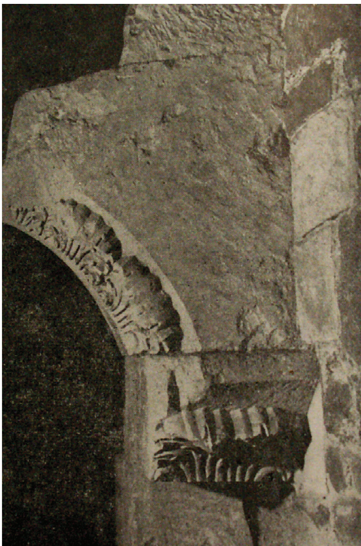
16. Krb v patře paláce, detail konzoly a výběhu oblouku dymníku
