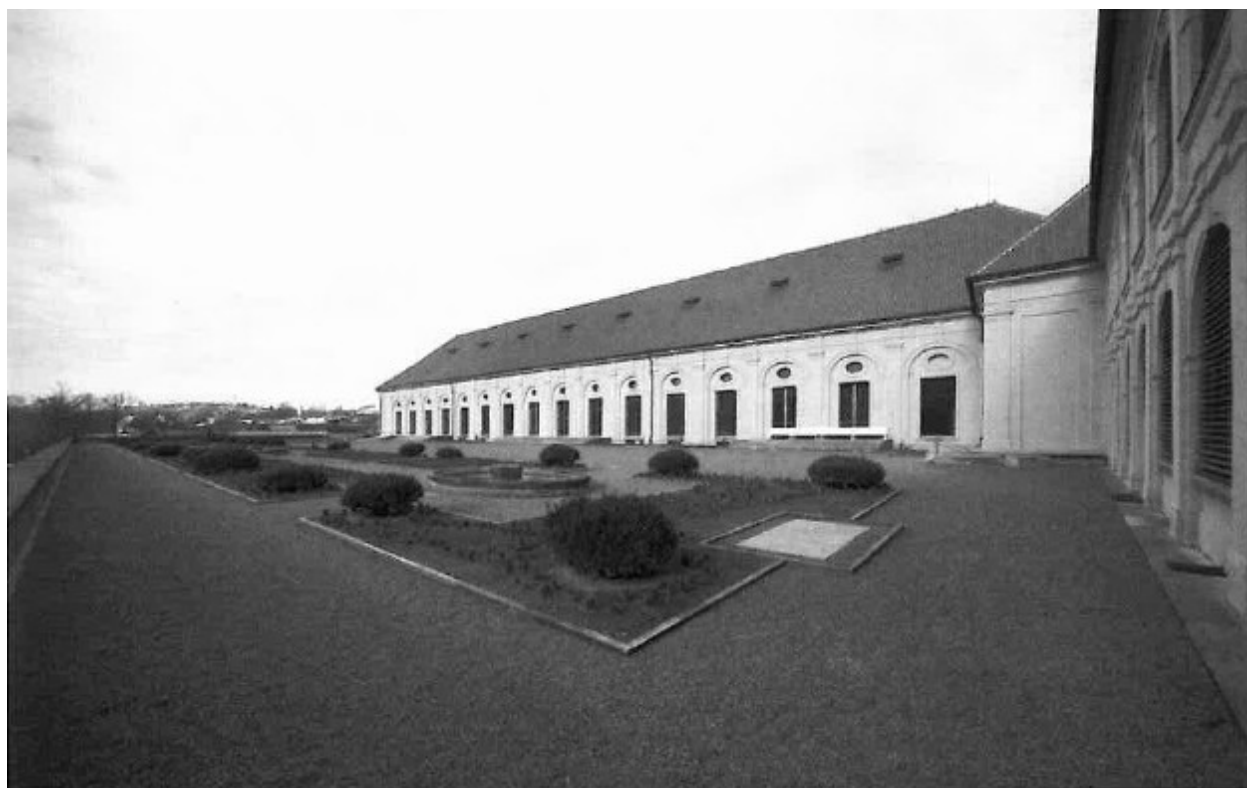
obr. č. 3 Prostory letní jízdárny (východní strana) 94
