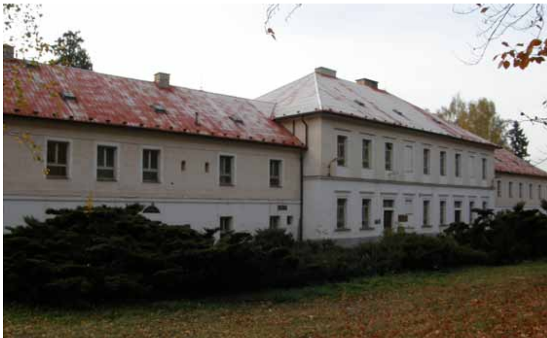
Příloha č. 5: Celkový pohled na zámek z východu, současný stav (obrázek)
