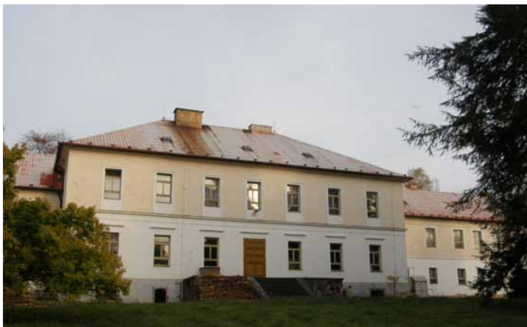
Příloha č. 4: Celkový pohled na průčelí zámku ze západu, současný stav (obrázek)
