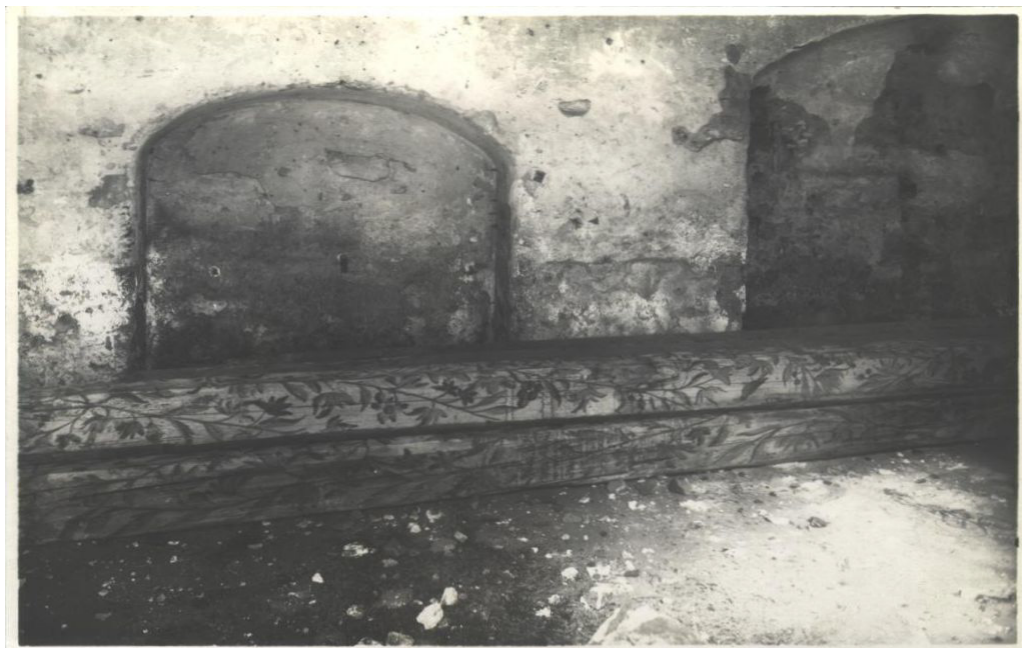
Obr. 2 Malby na stropních trámech domu čp. 298 v Konviktské ulici, které byly objeveny při bourání objektu. AMP, Sběrka fotografií, sign. I 9583, foto Antonín Alexander, 27.4.1934
