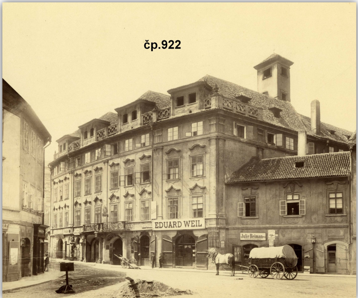
Obr. 8 Pohled na dům čp. 922, tzv. „Starou kolkovnu“, v Dlouhé ulici. AMP, Sbíрка fotografií, sign. VI 2/41, foto Jindřich Eckert, kol. r. 1900
