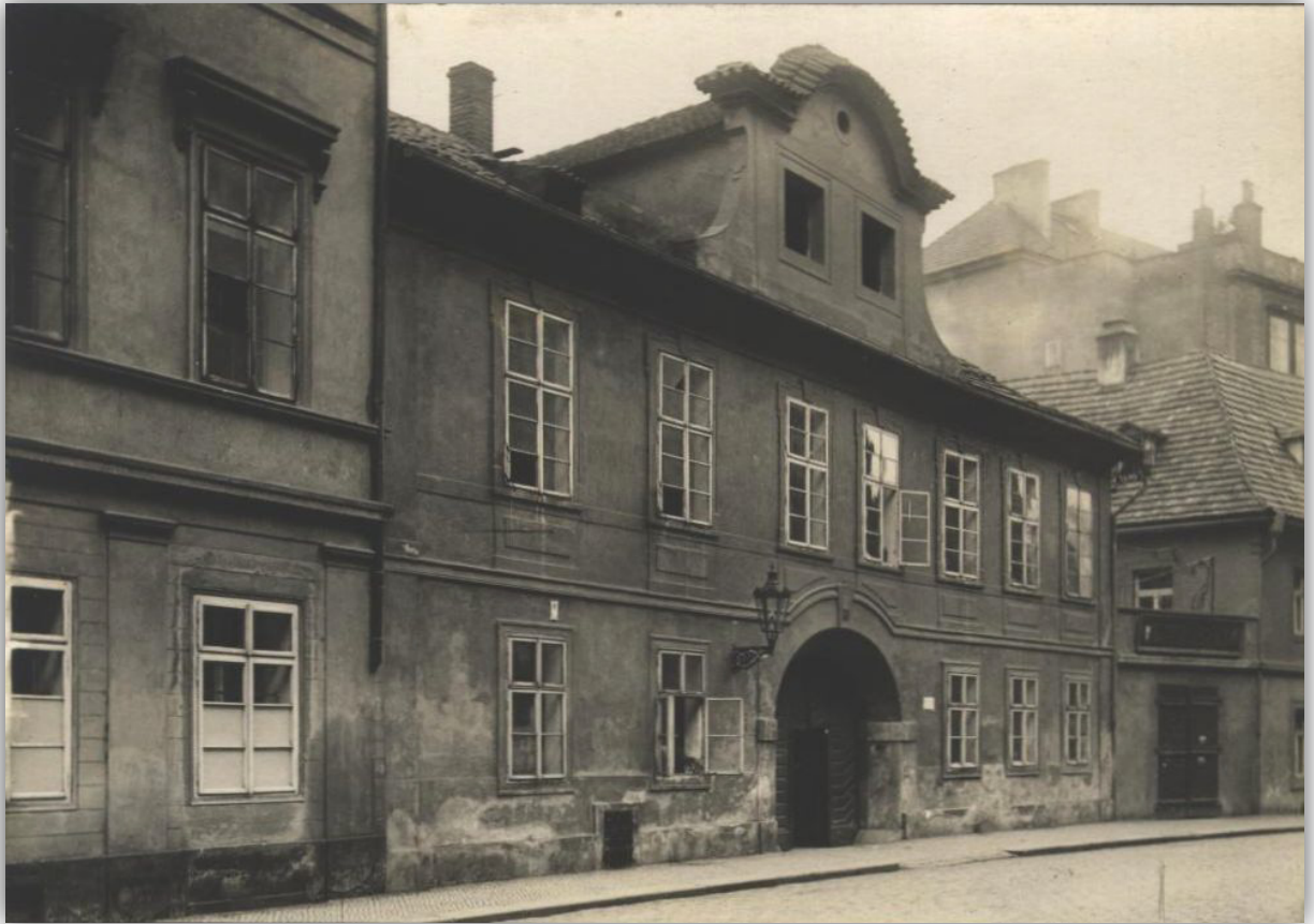
Obr. 1 Pohled na severozápadní průčelí domu čp. 298 v Konviktské ulici. AMP, Sběrka fotografií, sign. I 9583, foto Antonín Alexander, 1.3.1926
