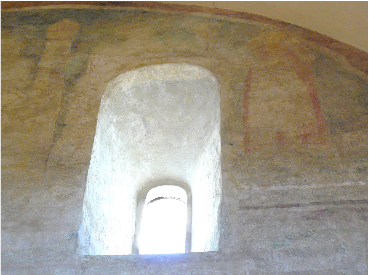
27b. Severní stěna, pravá strana lunety.
