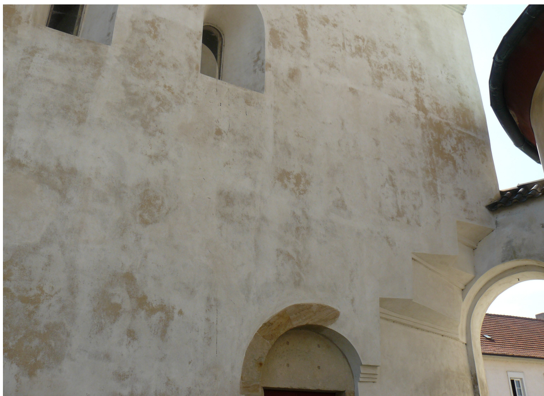
14b. Stará Boleslav, severní stěna kostela sv. Klimenta, pohled na druhotné vykrojení nároží dotýkající se ostění portálu, detail.
