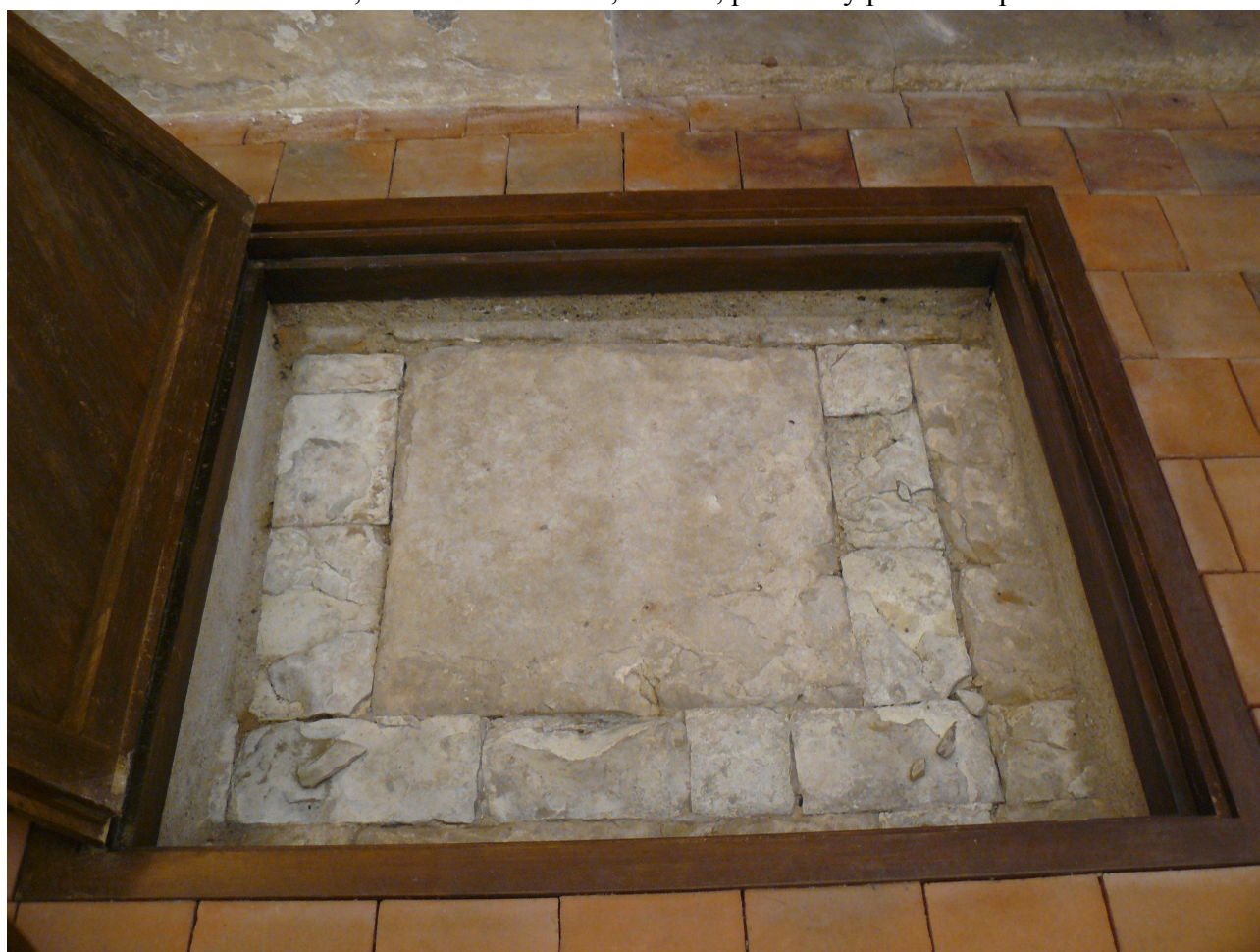
19. Stará Boleslav, kostel sv. Klimenta, pohled na původní kamennou dlažbu.
