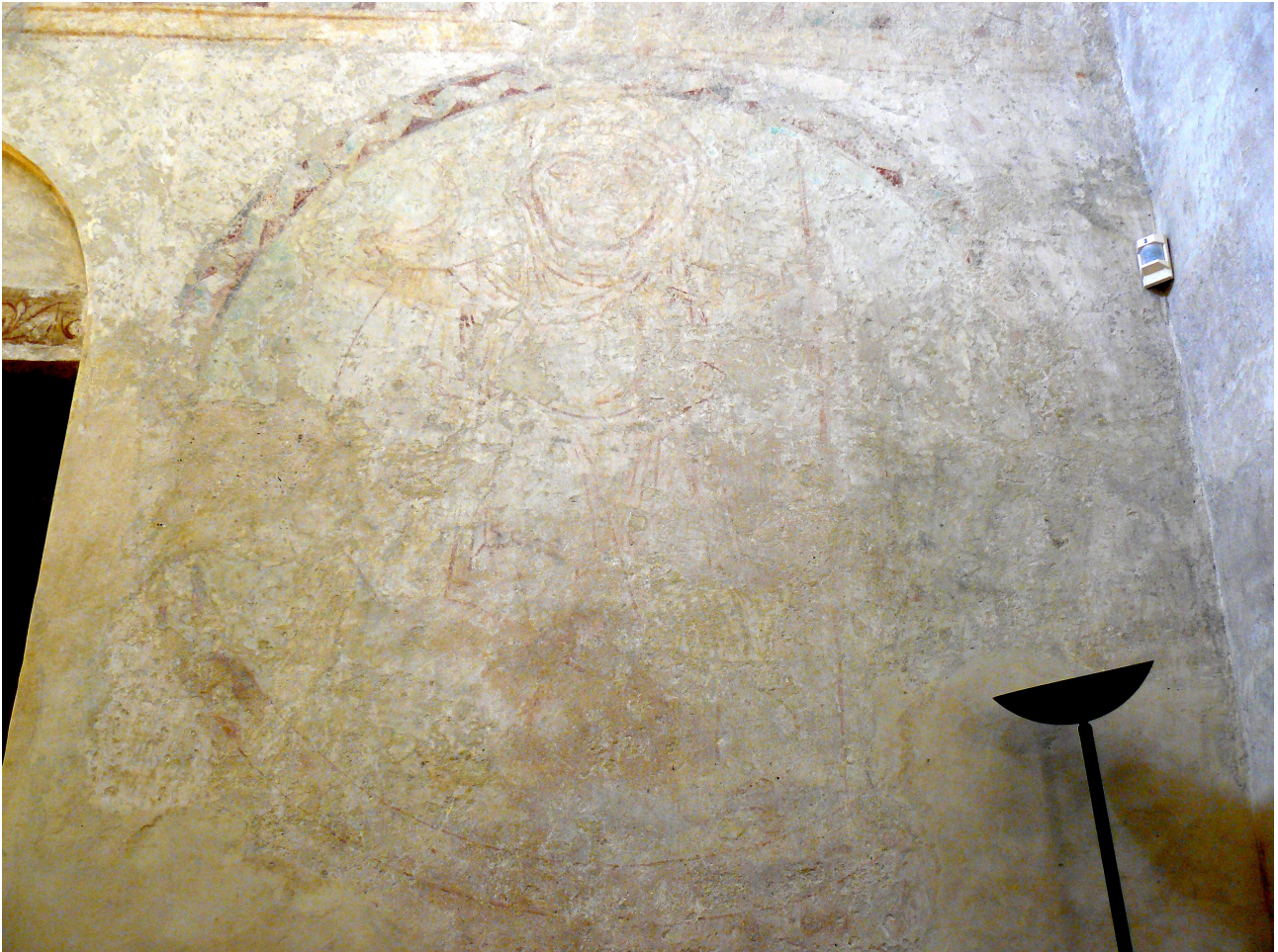
25c. Západní stěna, severní strana, obrysová kresba překrývajících se postav.
