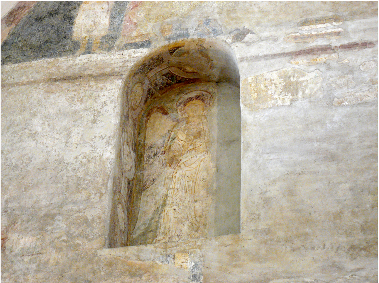
26b. Západní stěna, výklenek s postavou anděla.
