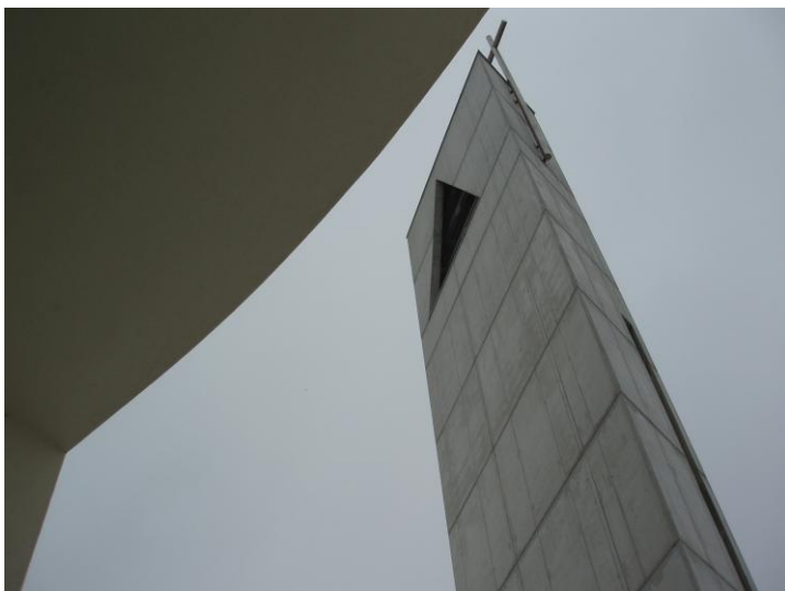
Obr. 3 Kostel sv. Ducha, Ostrava – zvonice
